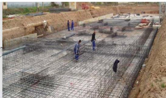
Figura 4: Losa de Fundación
