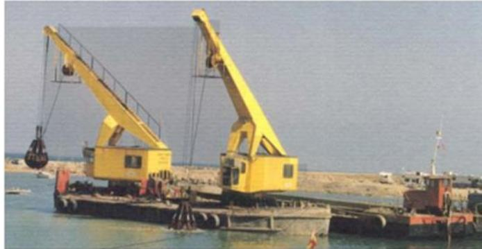
**Figura 2.14:** Dragas de cuchara sobre plataforma extrayendo material y cargando en gánguil. (Fuente: [www.ceda.com](http://www.ceda.com))
