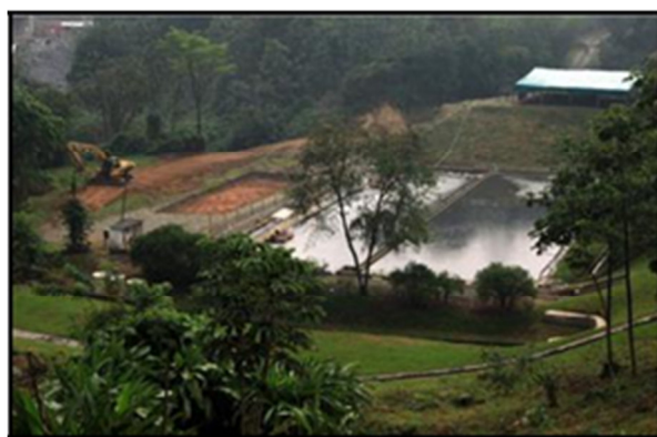
Figura 15. Sistema de tratamiento lixiviado relleno sanitario la Pradera Medellín (2015)
