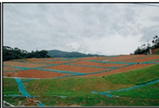
Figura 14. Clausura vaso - relleno sanitario la Pradera Medellín (2015)
