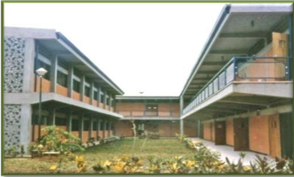
**Foto 5.** Sistema Tradicional Aporticado de Concreto ( STAC)
