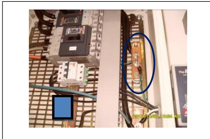
*Figura 44: Ubicación del interruptor y se muestra la barra de tierra en el tablero principal*
