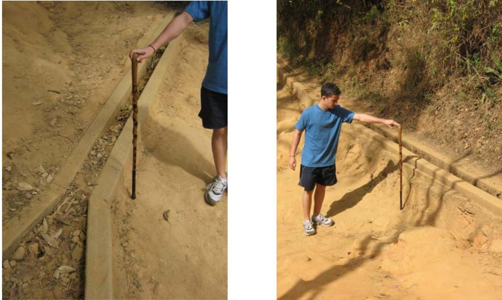
En esta foto se puede observar la erosión lateral de la obra de drenaje ubicada en el Parque Nacional El Ávila, producto de la colmatación de sedimentos de la misma, disminuyendo así su capacidad de transporte y produciendo como consecuencia la erosión de la obra en toda su longitud.
