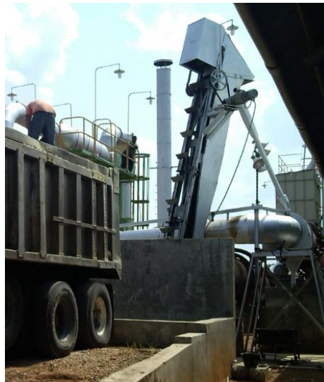
Figura 9 Tolva de recepción y Elevador de Canjilones de la empresa CALCA
