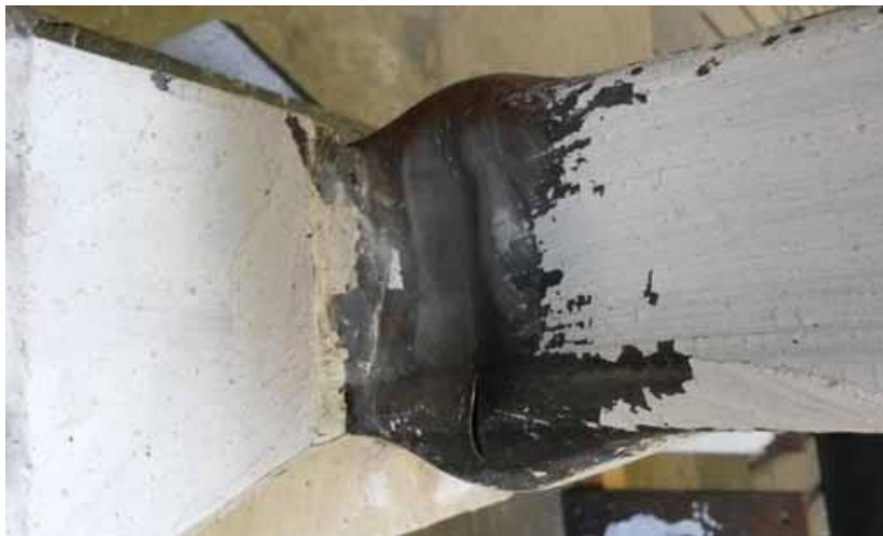
Figura VI.32 Agrietamiento final del ala del perfil tubular rectangular usado como viga. Ensayo #2
