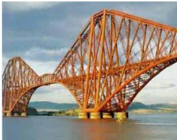
Figura II.1 El puente Firth of Forth en Escocia (1890), unas de las primeras experiencias con perfiles tubulares circulares (Wardenier 2001)
