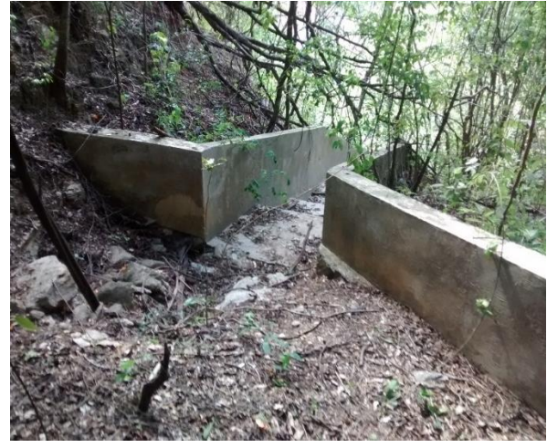
Notase como existe el espacio para la rejilla de captación en el primer escalón
