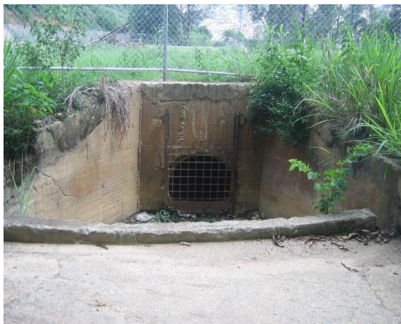
Estructura disipadora y cabezal de la alcantarilla
