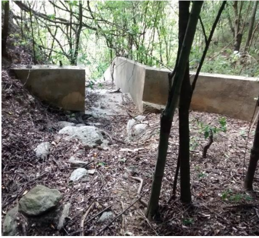
Al margen derecho se puede observar el espacio destinado al desarenador.
