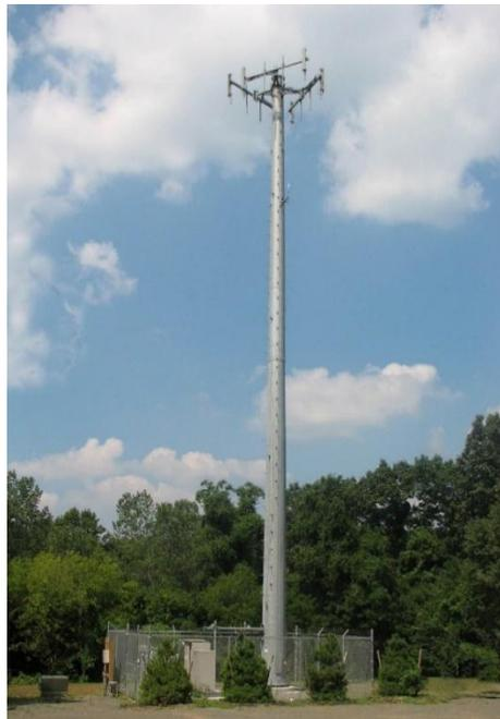
Figura II.5 Monoposte de sección variable sobre terreno.
