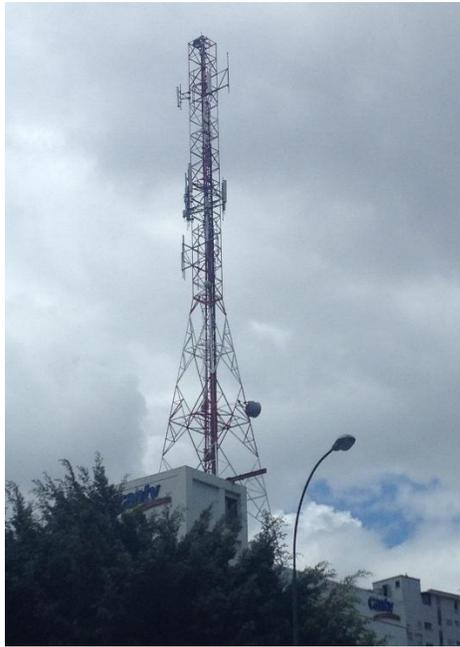
Figura II.2 Torre autoportada cuadrada de sección variable sobre azotea.
