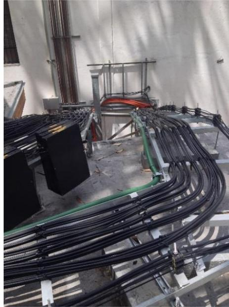
Figura II.17 Escalerillas horizontales de guía de onda.
