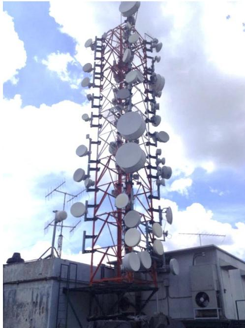
Figura II.31 Torre con múltiples antenas parabólicas, se observa la configuración de su soporte.
