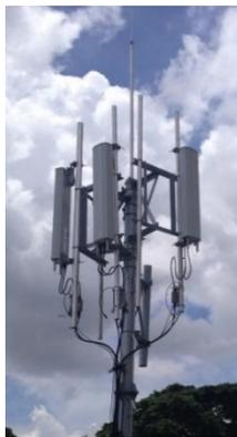
Figura II.35 Soporte para páneles celulares en monoposte.
