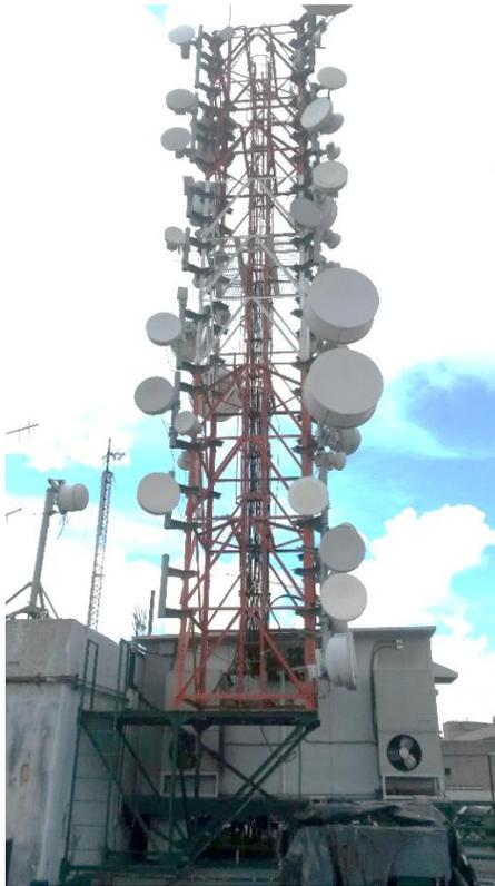
Figura IV.5 Torre con estructura de transición anclada horizontalmente al núcleo de ascensores.
