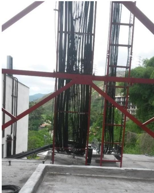
Figura II.16 Escalerillas verticales de guía de onda en toda la longitud de la torre.
