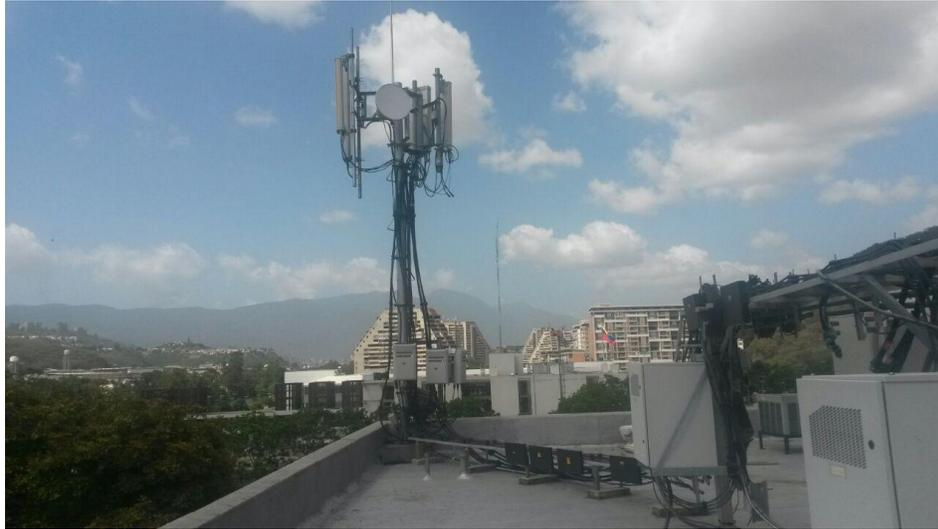
Figura II.6 Monoposte de sección constante sobre azotea.
