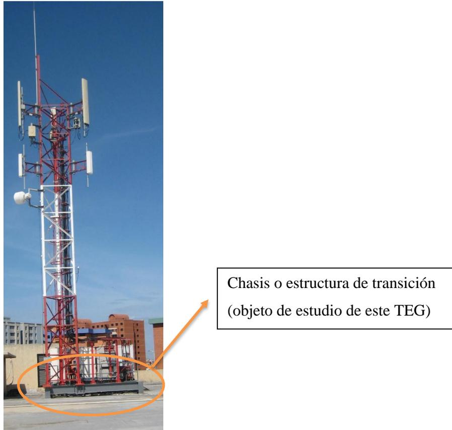
Figura IV.4 Foto de torre y estructura de transición
