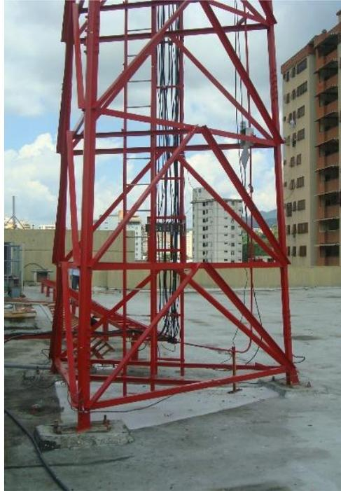
Figura IV.3 Torre anclada directamente sobre la losa de techo de la edificación.
