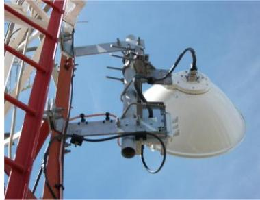
Figura II.33 Detalle de soporte para antena parabólica en una montante.
