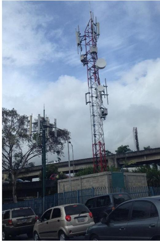
Figura II.3 Torre autoportada triangular de sección constante sobre terreno.
