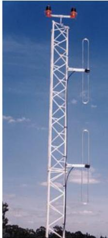
Figura II.22 Antenas dipolo en torre de telecomunicación.
