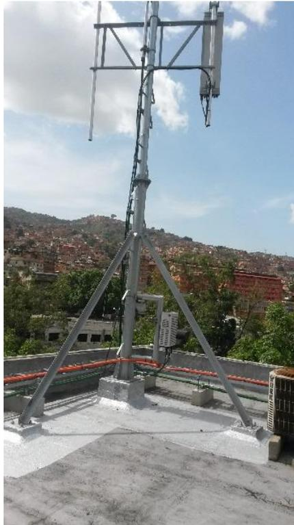
Figura IV.2 Soporte en forma de Trípode con perfiles angulares para Monopolo
