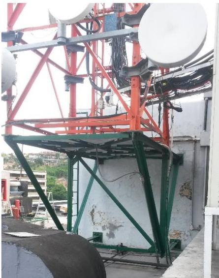
Figura IV.6 Detalle de estructura de transición anclada al núcleo de ascensores.
