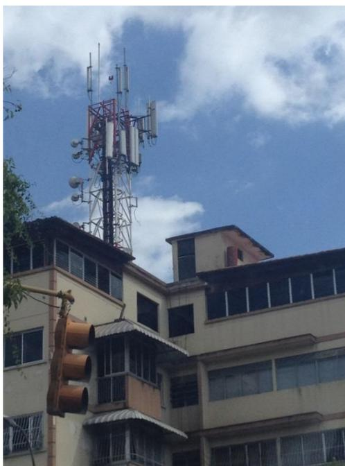
Figura II.1 Torre autoportada cuadrada de sección constante sobre azotea.
