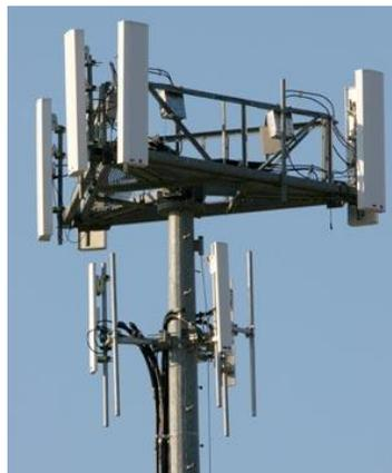
Figura II.21 Antenas de microstrip en monoposte.
