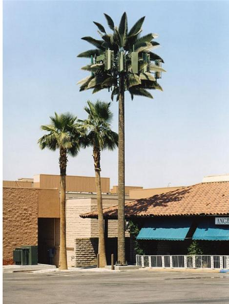
Figura II.7 Monoposte mimetizado sobre terreno.
