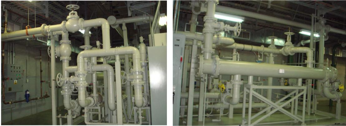
**Figura N° 2.** Sistema de tuberías para el enfriamiento del Generador.
