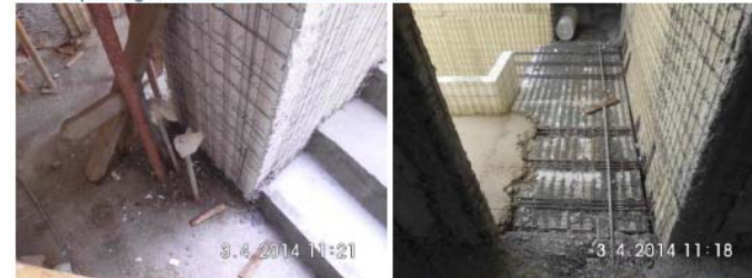
Muro de Soporte de losa de escalera sin proyectar y escalera vaciada
