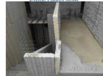
Muro de Soporte de losa de escalera sin proyectar y escalera vaciada
