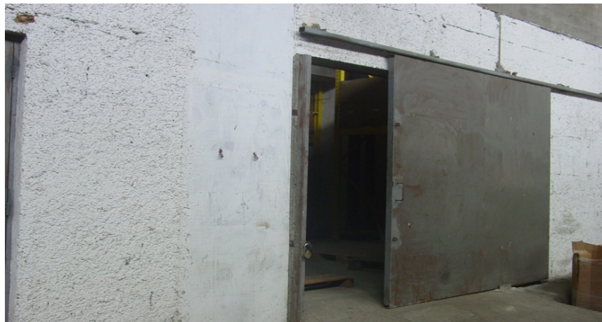
Ilustración Nro. 6. Almacén Pulmón 2. Puerta Area Almacén
