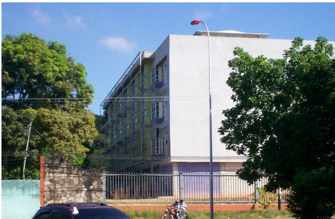
Figura 4. Módulo I y II, Hospital Central “José Gregorio Hernández”. Fachada Posterior
