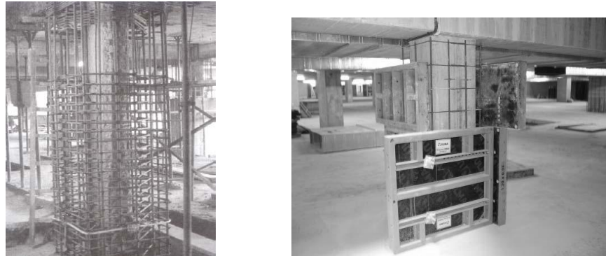
Figura 22. Aspecto típico de una columna durante el proceso de ejecución de un refuerzo con encamisado de concreto armado.
