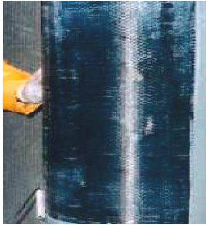
Figura 25. Columna encamisada con polímeros reforzados con fibras de carbono CFRP
