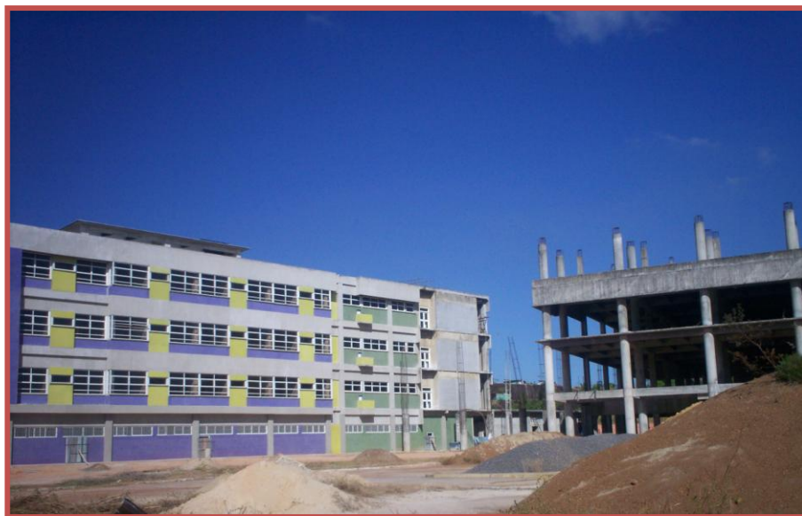
Figura 1. Bloque 1; Módulos I y II (izquierda) y Bloque 2 (derecha) del Hospital Central “José Gregorio Hernández”
