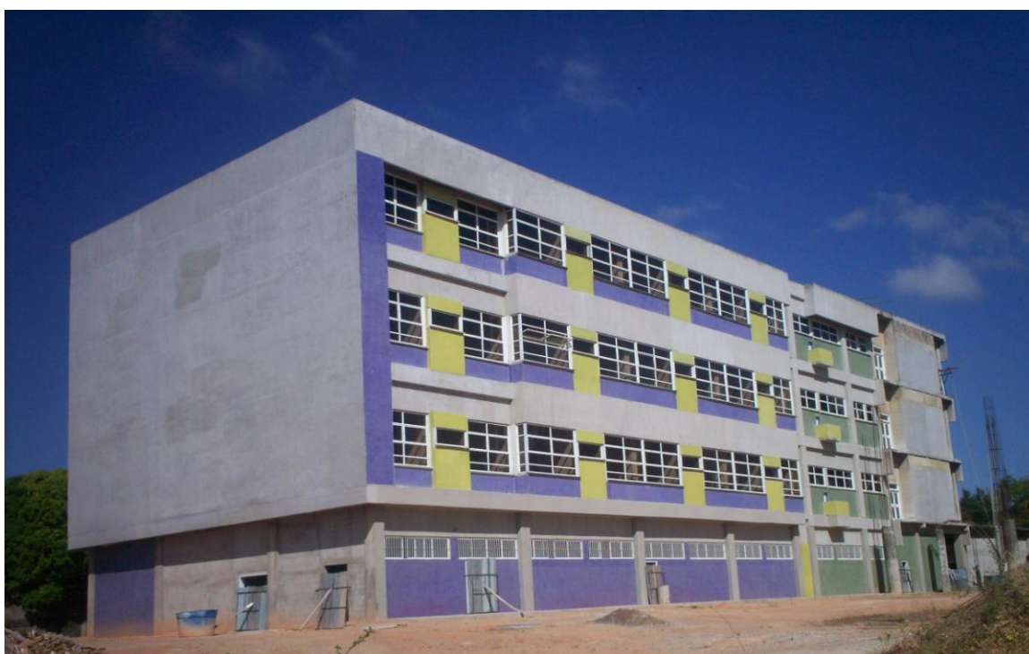
Figura 3. Módulo I y II, Hospital Central "José Gregorio Hernández". Fachada principal
