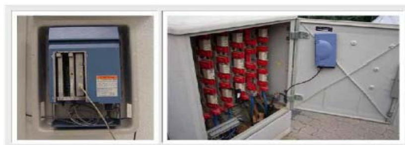
Figura 16. Repetidor BPL
