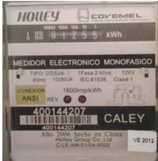
Figura 12. Especificaciones del Medidor de Consumo Eléctrico. Autoría Propia.
