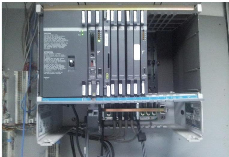
**Anexo D. Central telefónica Meridian de Nortel, actualmente en funcionamiento en la empresa.**
