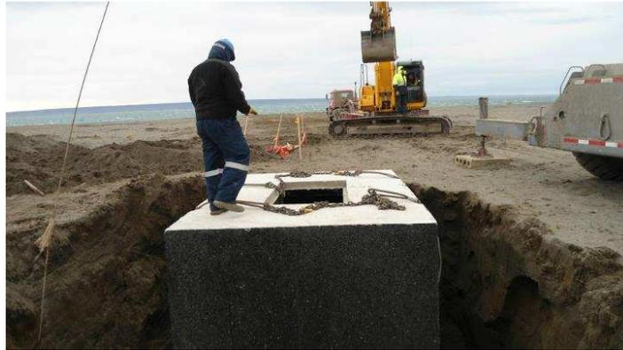
Figura 31. Colocación de una Cámara de Amarre.
