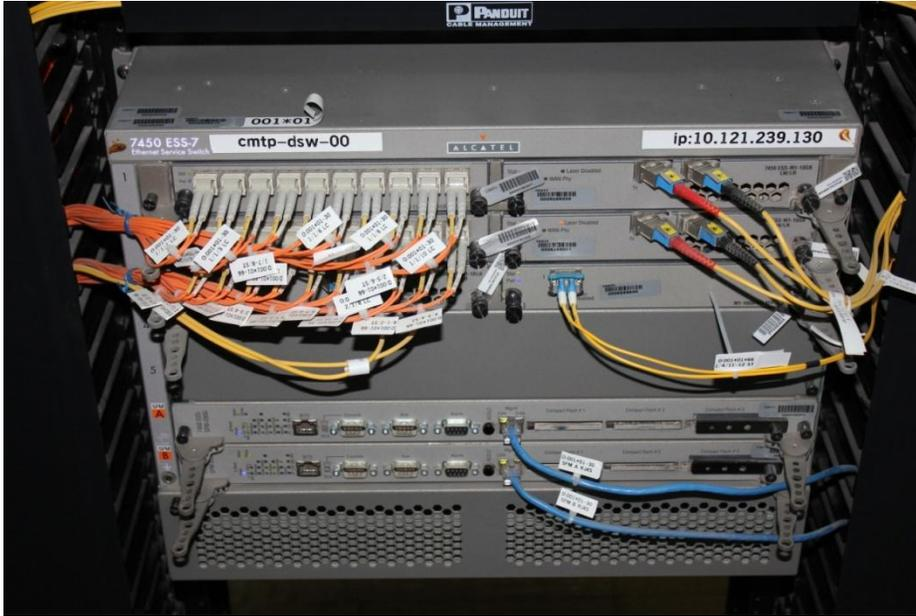
**Figura 12 Switch de distribución red Metro-Ethernet**
