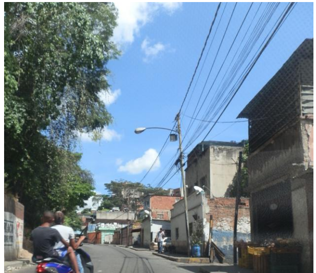
Foto 20. Carretera Petare- Sta. Lucía, luminaria lateral de un brazo.
