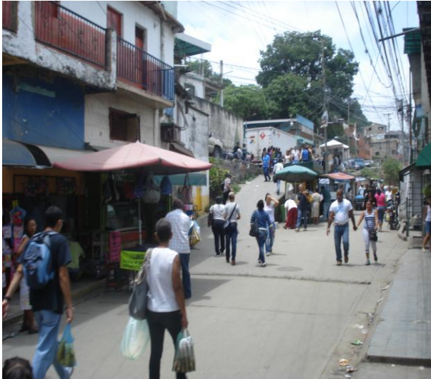
Foto 3. Calle La Línea, calzada de pavimento rígido con dislocamiento y fisuras, uso exclusivo peatonal, con ocupación a los extremos del comercio informal.
