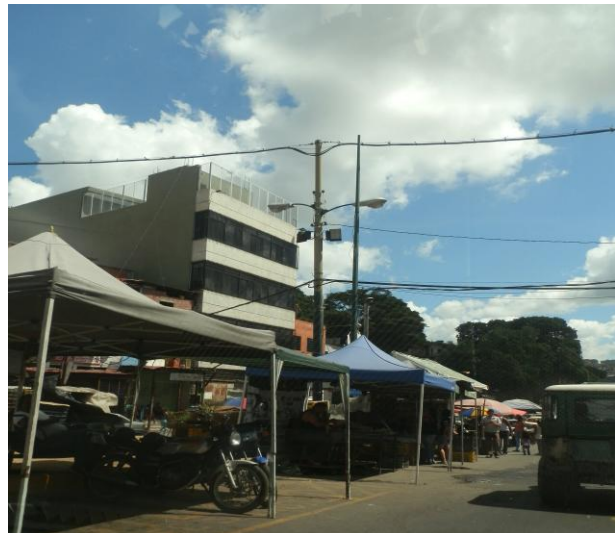
Foto 11. Calle Federación, isla central, luminaria central de dos brazos y reflectores adicionales.
