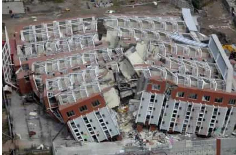
**Figura 2-2: Falla catastrófica del edificio Alto Río**
