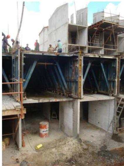
**Figura 4-2: Edificio con sistema tipo túnel en construcción**
