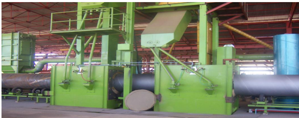
Figura 7: Etapa de preparación de la superficie, granallado externo. Fuente: Manuales de PGJAA
