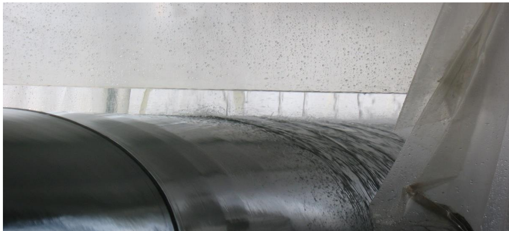
Figura 17: Lavado del tubo en la batea de enfriamiento. Fuente: Manuales de PGJAA
