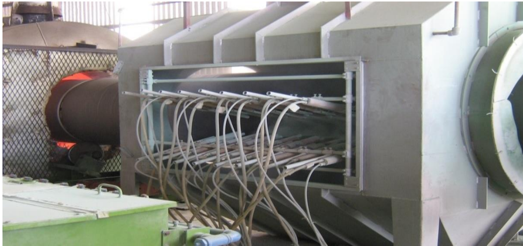
Figura 14: Aplicación de resina epóxica. Fuente: Manuales de PGJAA
