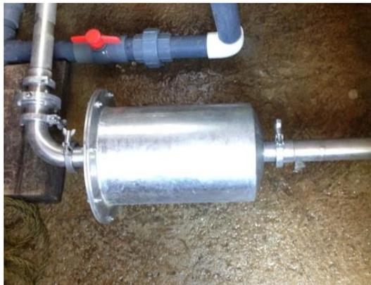
**Figura 5. Filtro de Eliminación de Residuos**
