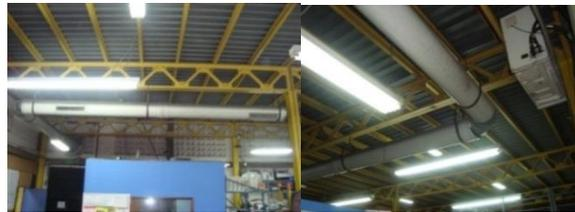
**Figura N° 35: Ductos de inyección de aire inoperativos.**
