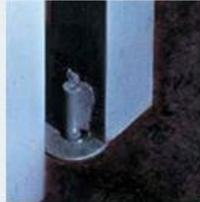
El pasador de caída se desliza dentro de un agujero del mismo tamaño y se asegura mediante un ángulo triangular en el riel opuesto de la puerta.
