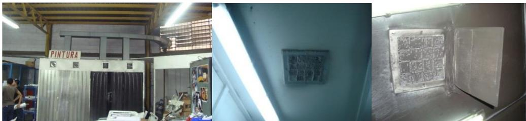
**Figura N° 33: Área de pintura y soplado de tóner (izquierda), Ductos de extracción de pintura (centro) y tóner (derecha).**
