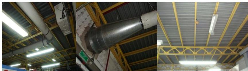
**Figura N° 52: Ductos a remover, ventilador axial existente en producción y cerchas en el techo.
