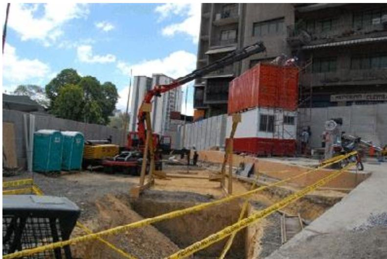
Ilustración 21. Ejemplo de condiciones inseguras presente en el área de trabajo
