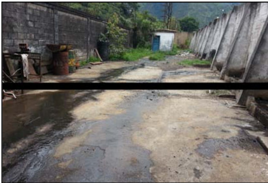
Drenaje de lixiviados detrás del patio de vertido
