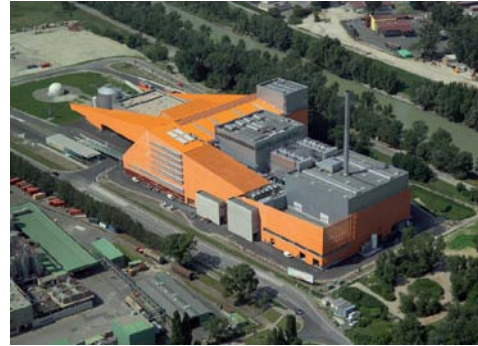
Planta Incineradora “Pfaffenau” Austria
