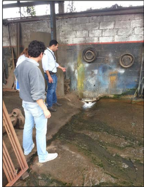
Vertido de lixiviados al canal de lluvias de la carretera
