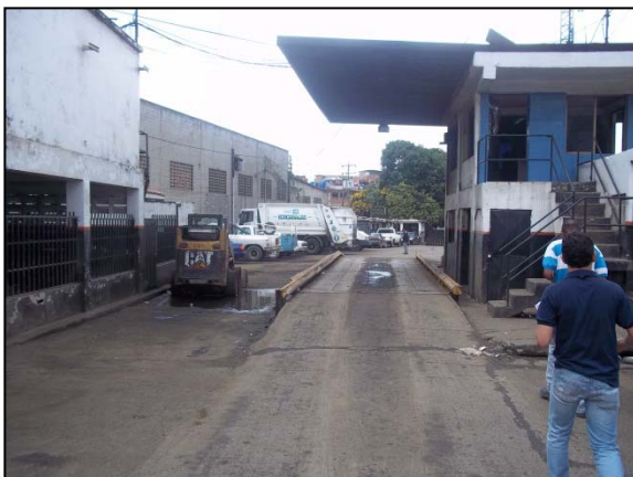
Entrada a la ET con romana y casilla de control
