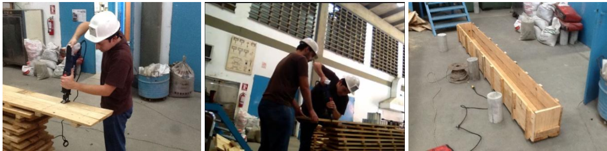
Figura 3.1.-Elaboración de encofrados
