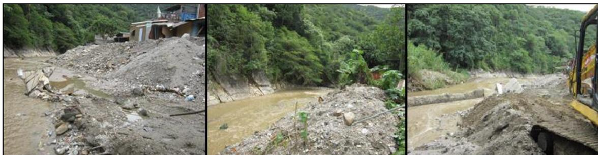
FOTO 5.4 Viviendas afectadas por eventos de crecida (Izquierda); tipo de vegetación y sedimentos (Centro); muro de canalización descalzado (Derecha). (Fuente: Propia)
