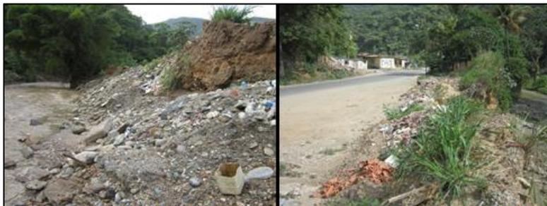
FOTO 5.6 Procesos erosivos en la margen derecha (Izquierda); vialidad y viviendas en la margen derecha (Derecha). (Fuente: Propia)
