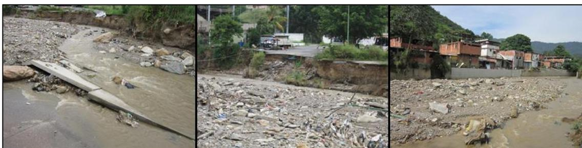
FOTO 5.2 Muro descalzado del margen izquierdo y sedimentos de arrastre (Izquierda); pérdida de parte de la capa de rodamiento del pavimento correspondiente al estacionamiento de las instalaciones deportivas producto de la socavación del terreno en la margen izquierda (Centro); sedimentos de arrastre y descarga directa de viviendas ubicadas en la margen derecha (Derecha). (Fuente: Propia)
