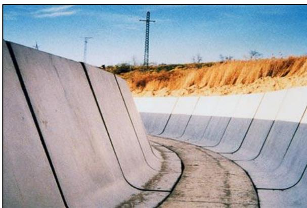
Fig. 3.20 Ejemplo de uso de materiales prefabricados (Fuente: Google)
