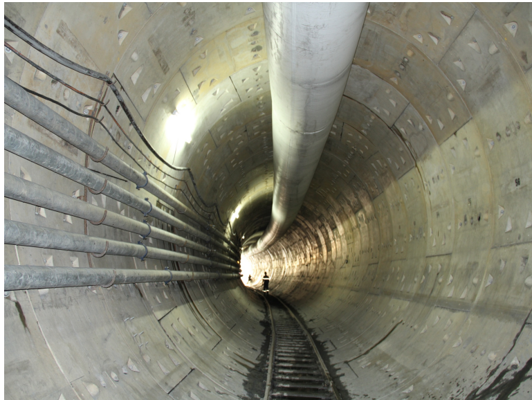
FIGURA 2.2.c: Túnel gemelo UNEFA-Chuao, revestido con los anillos prefabricados.
