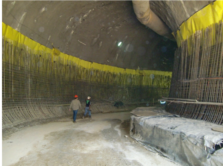
FIGURA 2.4.d.: Túnel minero de conexión en Bello Campo. Revestimiento final.
