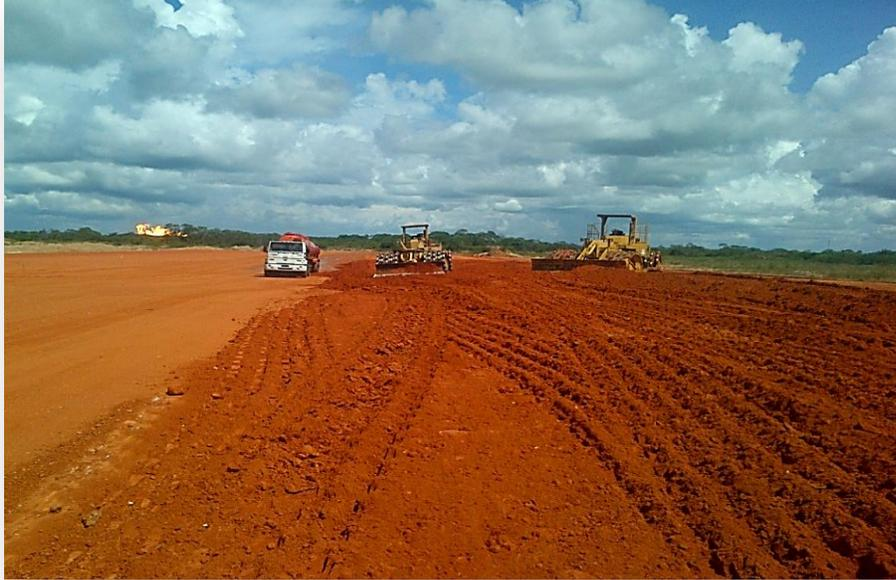
Anexo 7. **Proceso de Compactación con uso de Pata de Cabra** (Obra "Preparación de sitio, proyecto planta de extracción profunda soto")
