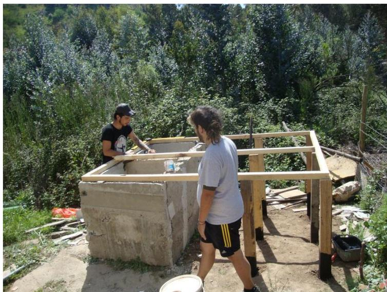
Figura 26. Construcción de un baño externo en las montañas de Belloto, Chile.<sup>59</sup>
