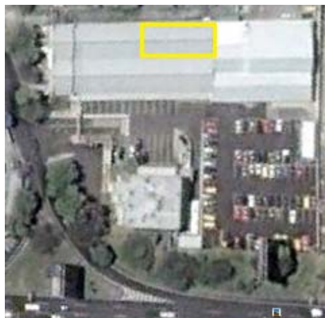
Figura 2: Señalización del área de Recepción de Camiones VAS en las instalaciones de DHL Express La California
