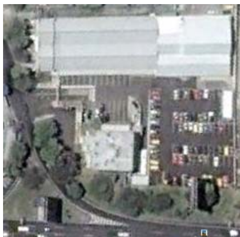
Figura 1. Vista aérea de las instalaciones de DHL Express en La California Sur
