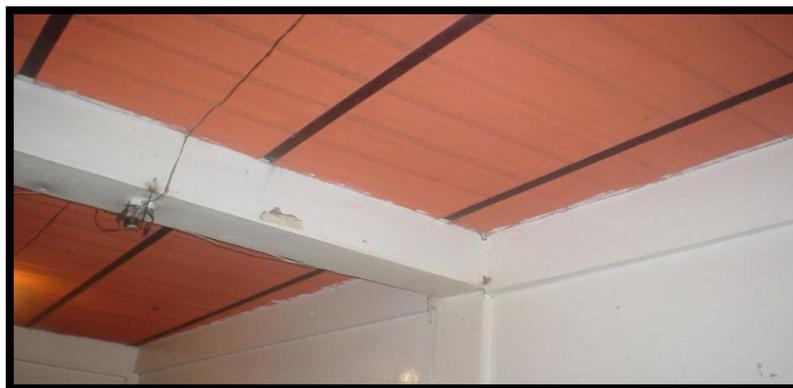
Ilustración N° 11: Losa de tableros, de frecuente uso en viviendas de carácter utilitario.
