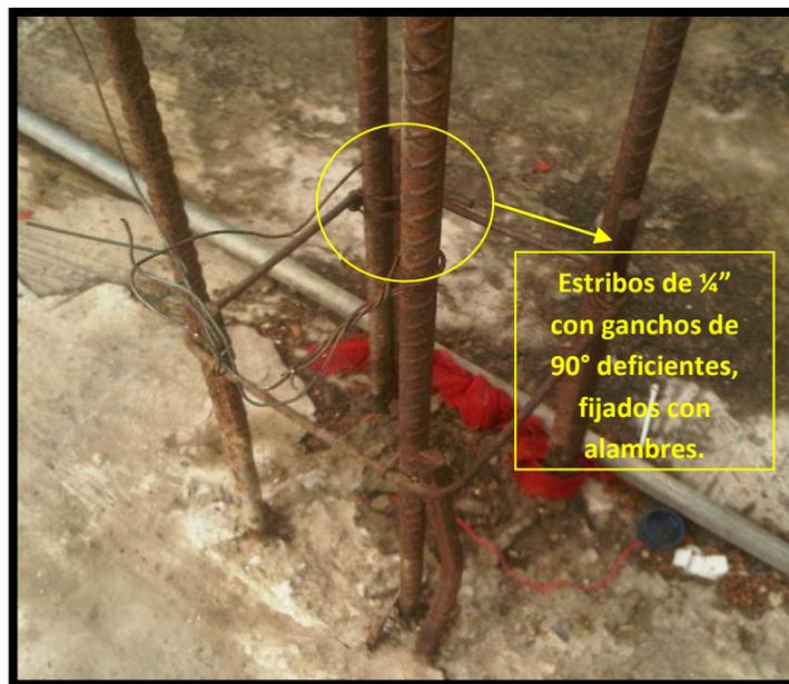
Ilustración N° 16: Barras de acero usadas como refuerzo de miembros, expuestas al ambiente.
