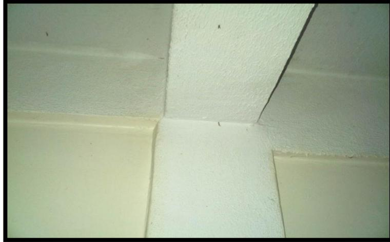
Ilustración N° 8: Cambio de rigidez en intersección de vigas con columna.
