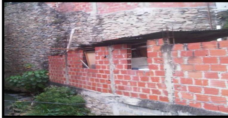
Ilustración N° 6: Muro de mampostería confinada. |
