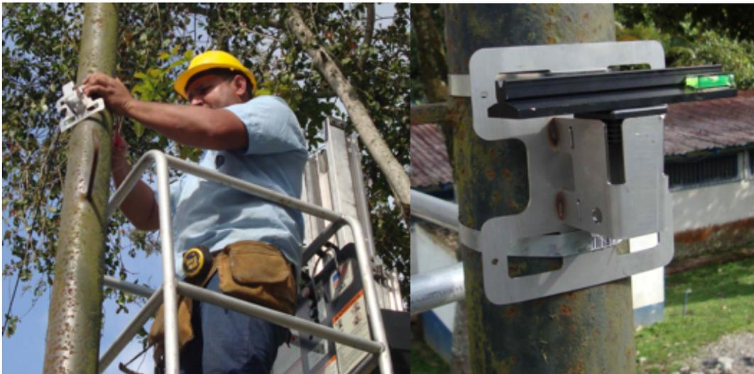
Figura 12. Instalación de la base del radar TMS-SA.
