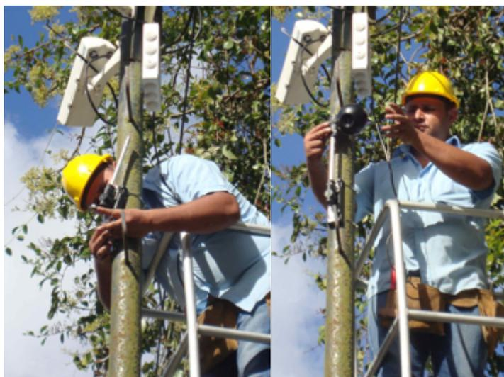
**Figura 14. Instalación de la base y cámara Collect-R x-stream.**
