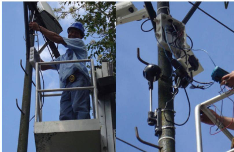
**Figura 13. Instalación de la caja de conexiones eléctricas.**
