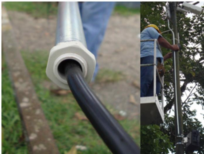
**Figura 15. Instalación del cable de carga del radar TMS-SA.**
