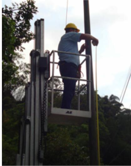
Figura 11. Medición del poste y diferentes alturas necesarias para la instalación de los equipos.
