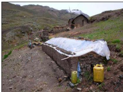
**Ilustración 21.** *Biodigestor Familiar Tipo Tubular, Régimen Continuo*
