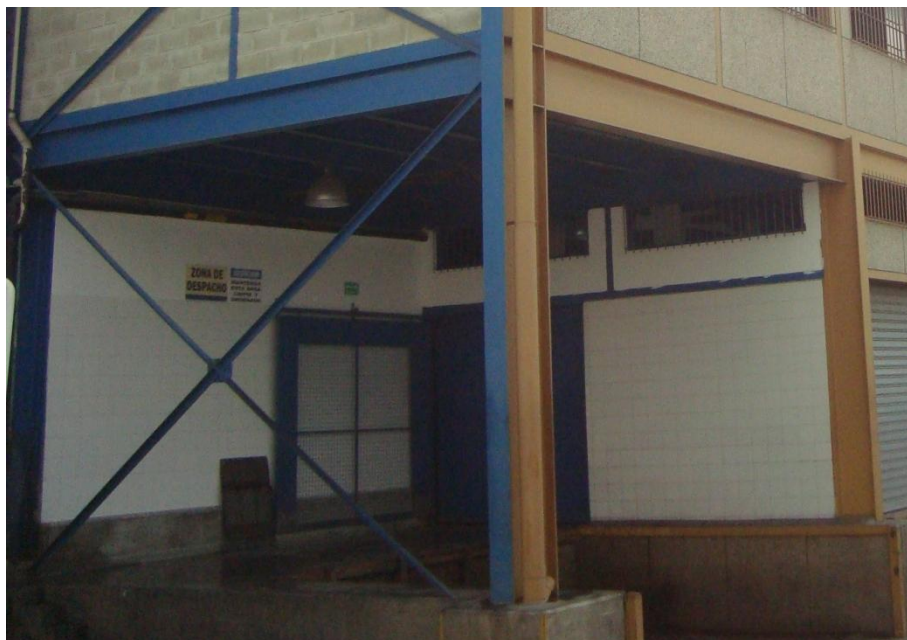
Figura 50.- Muelle de despacho. Fuente: Cámara fotográfica.
