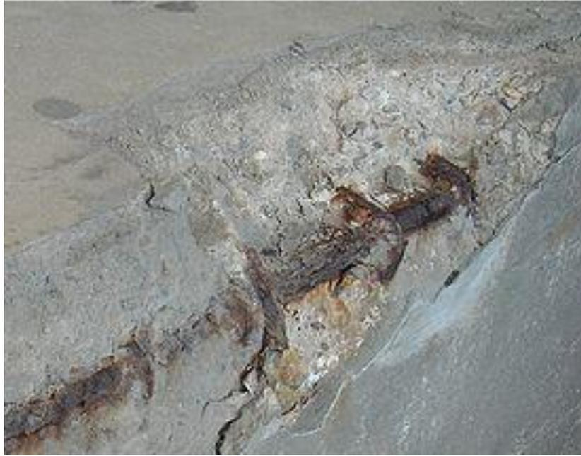
**Figura 9. Fisuras y desprendimiento de concreto causados por corrosión localizada y Carbonatación.**
