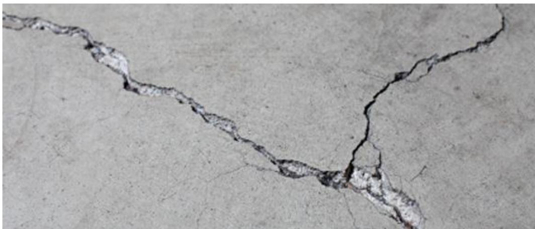
**Figura 8. Fisuración por reacción química.**
