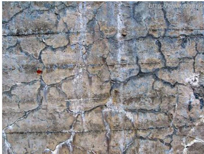
**Figura 6. Fisuración por reacción Alkali-Silice.**
