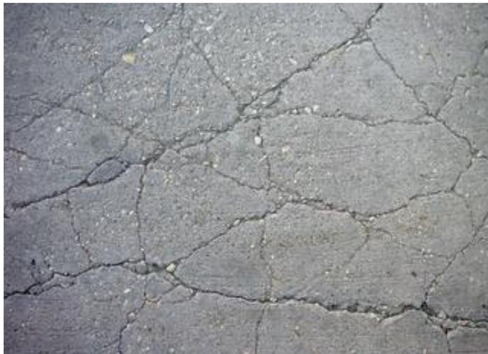
**Figura 7. Fisuración por reacción Alkali-Carbonato.**
