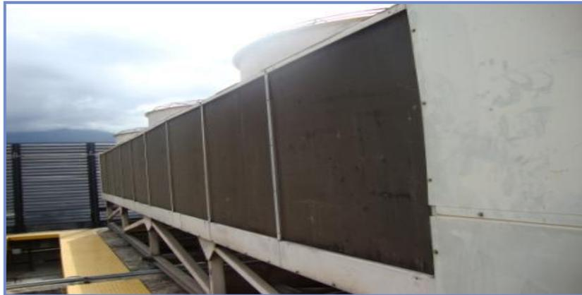
Anexo A. 5 Vista del condensador del chiller enfriado por aire.
