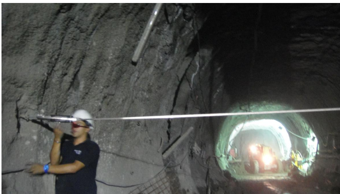
Medición de convergencia de las paredes del túnel
