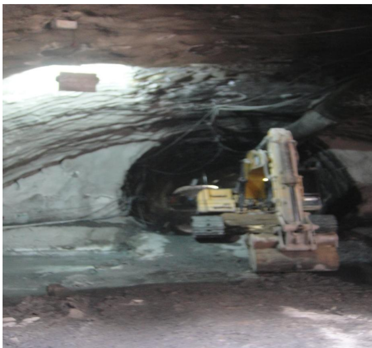
Excavación de túnel
