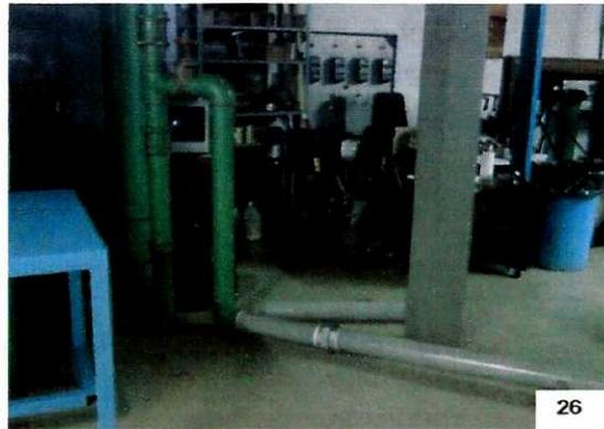
**Tramo 2:** Desde la toma directa hasta el lugar más cercano al tanque subterráneo para la salida del agua del micromodelo con un recorrido de 5,87 metros y un diámetro de 10 cm (4 pulgadas).
