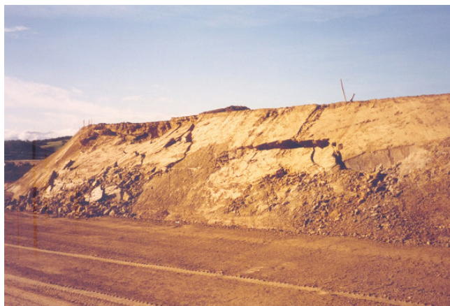
Foto N° 1-3: Deslizamiento sobre el flanco Este de la Terraza 6 (Noviembre 1.993).
