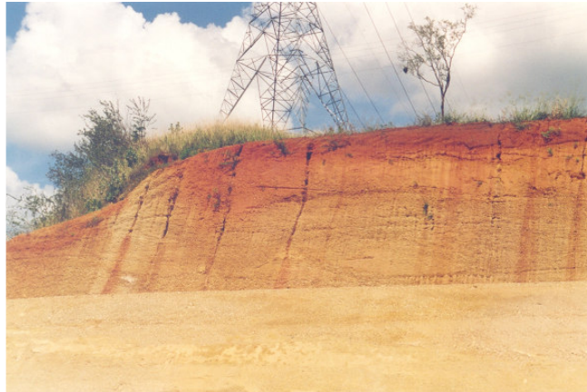
Foto N° 1-4: Sector superior del talud de corte localizado entre la Terraza 7 y el sector que se destina para la caseta y la torre de microondas (Noviembre 1.993).
