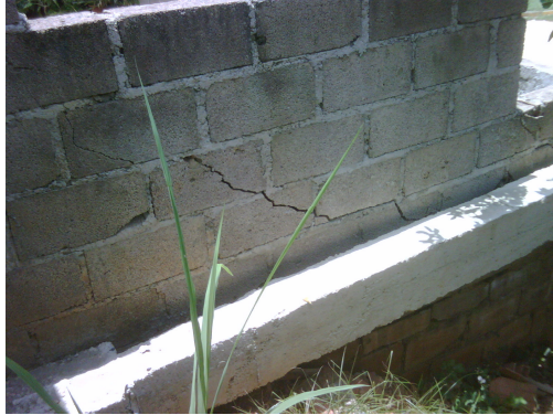
Foto N° 3-20: grieta en la pared ubicada sobre el talud (Septiembre 2.010).
