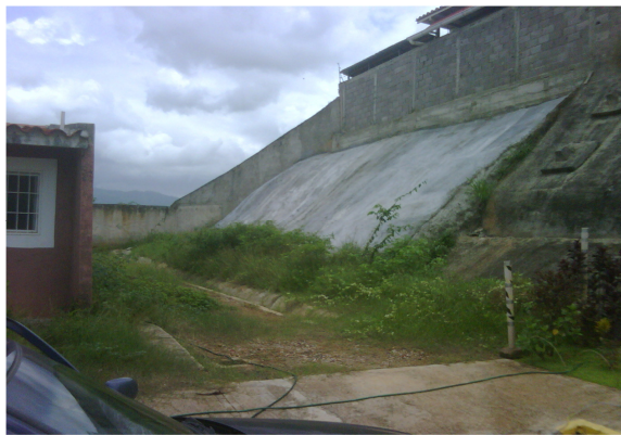
Foto N° 3-13: Pantalla de concreto entre parcelas 26(H1) y 31(G1) (Junio 2010).
