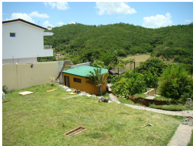
Foto N° 5-5: Vista del jardín el día en que se presentó la falla, sólo existían dos sumideros (Agosto 2.008).
