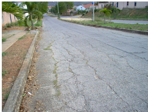
Foto N° 3-35 (izq): Grietas longitudinales en el pavimento, Av Principal Las Colinas (Febrero 2.003).
