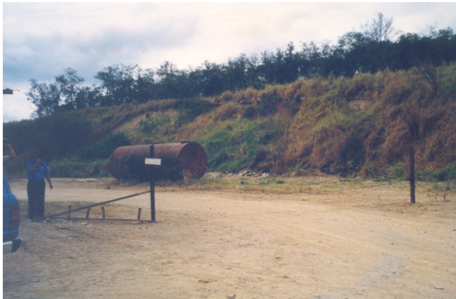
Foto N° 2-2: Vista panorámica de la falla Oeste (1.998).
