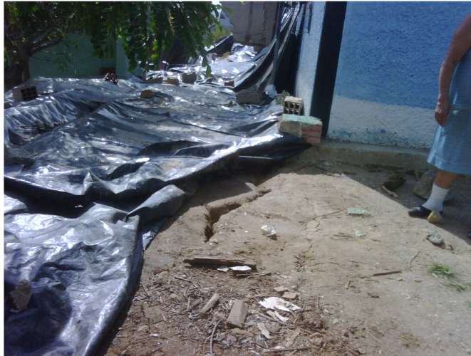
Foto N° 7-5: Vivienda 29-B (Septiembre 2.010).
