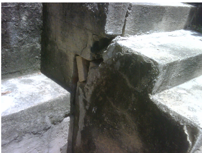
Foto N° 6-4: Grieta atravesando escalera exterior de la vivienda (Agosto 2.010).
