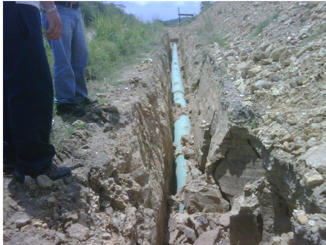
Foto N° 7-2: Colapso de la zanja al pie del talud (Septiembre 2.010).
