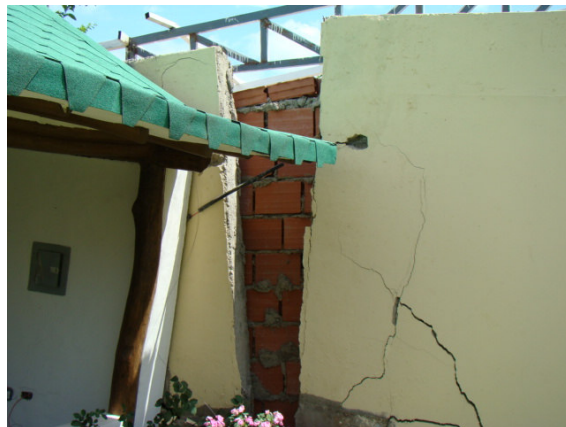
Foto 5-3: Rotura y volcamiento pared de lindero derecho (Agosto 2.008).
