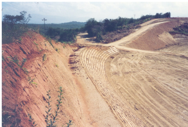
Foto N° 1-6: Vista parcial del Talud sobre la Terraza 7. En la esquina superior derecha se aprecia el talud reconstruido sobre la Terraza 8 (Noviembre 1.993).
