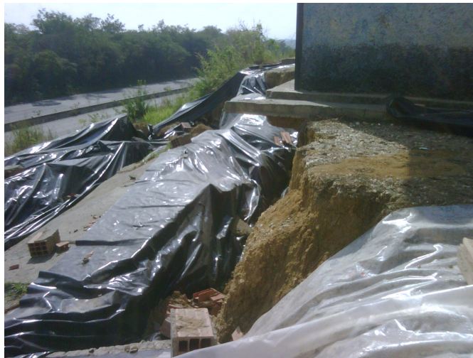
Foto N° 7-3: Vivienda 28-B. Losa en voladizo (Septiembre 2.010).
