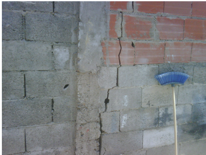
Foto N° 6-3: Grieta en pared de lindero (Agosto 2.010).
