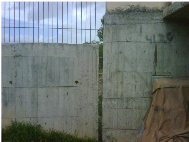
Foto N° 5-7: Vista muro lateral derecho entre la parte superior y la parte inferior del jardín al lado izquierdo de las escaleras (Julio 2.010).
