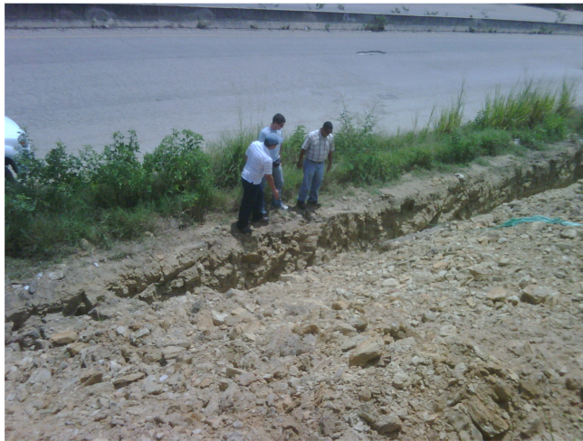
Foto N° 7-1: Zanja al pie del talud (Septiembre 2.010).
