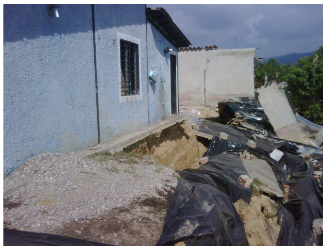
Foto N° 7-4: Vivienda 28-B (adelante) y 29-A (fondo) (Septiembre 2.010).
