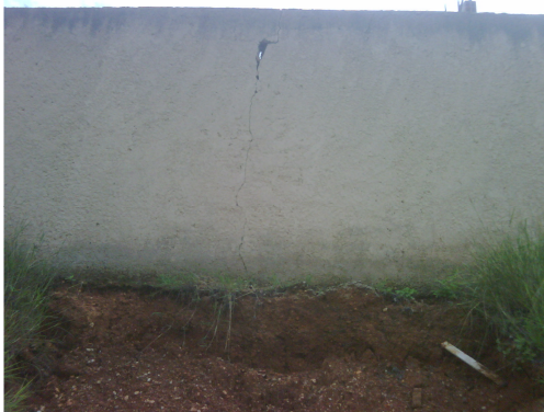
Foto N° 3-10 (izq.): Deslizamiento del talud entre viviendas 23 y 35 A, con agrietamiento en la pared (Junio 2.010).
