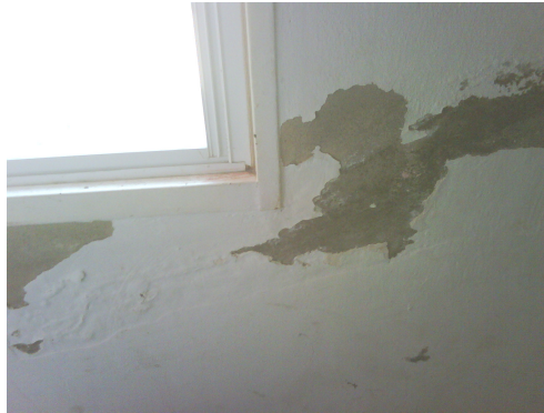
Foto N° 3-31: Humedad reflejada en las paredes dentro de la vivienda (Septiembre 2.010).
