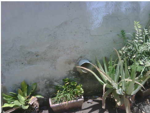
Foto N° 3-29 (izq): Tubo de drenaje de la parcela 68 que descarga en la parcela 69 (Septiembre 2.010).
