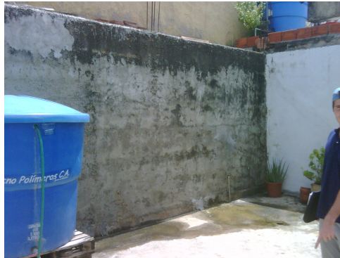
Foto N° 3-34: Humedad permanente en muro del patio trasero (Septiembre 2.010).
