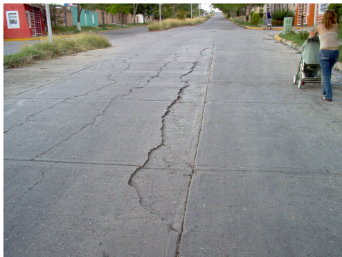
Foto N° 3-35 (izq): Grietas longitudinales en el pavimento, Av Principal Las Colinas (Febrero 2.003).
