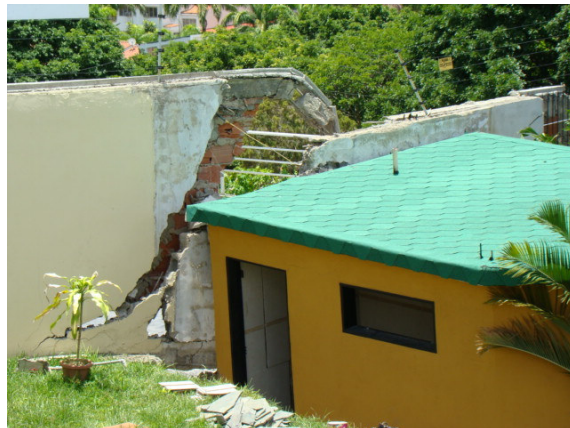
Foto 5-2: Rotura de pared del lindero izquierdo (izq) (Agosto 2.008).
