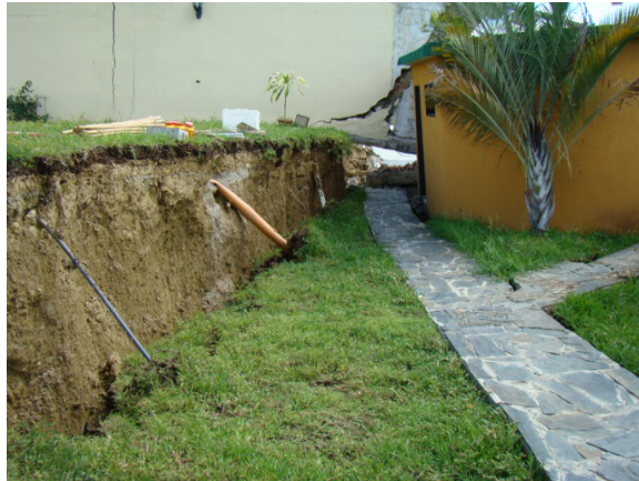
Foto N° 5-1: Asentamiento del terreno en el jardín (Agosto 2.008).
