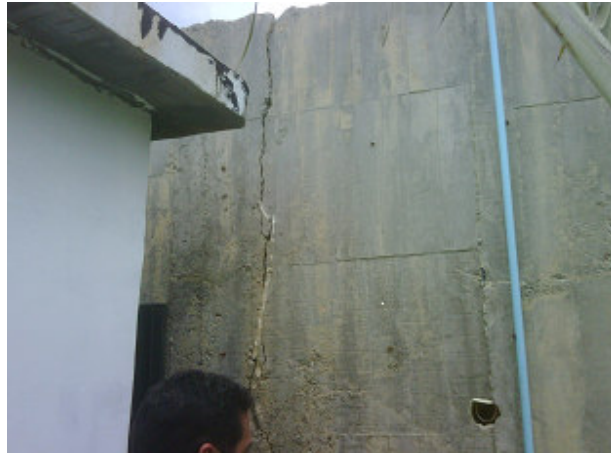
Foto N° 5-6: Vista del muro divisor de 3m de alto. Foto tomada desde el jardín inferior al lado del baño (Julio 2.010).
