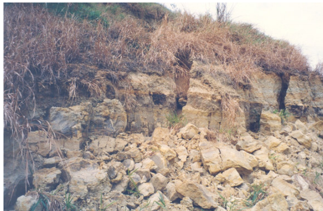
Foto N° 2-5: Escarpe del deslizamiento del talud Este (1.998).
