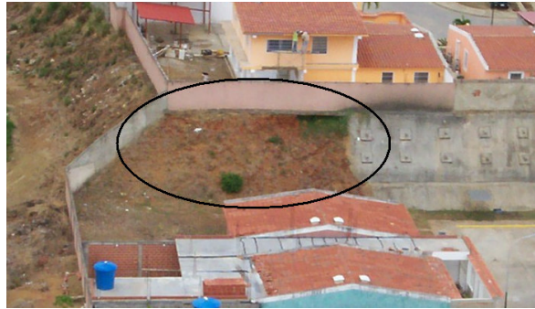
Foto N° 3-12: Talud socavado por el agua entre la parcela 26 (H1) y la parcela 31 (G1) (Marzo 2.007).
