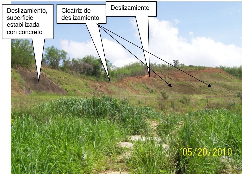
Foto 5-4: Vista panorámica de corte de la ladera norte de la urbanización Paso Real (Mayo 2010).
