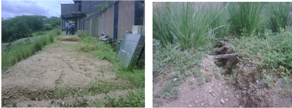
Foto N° 3-16 (izq): Cárcavas en talud externo a parcelas las 24, 25 y 26 (Junio 2.010).
