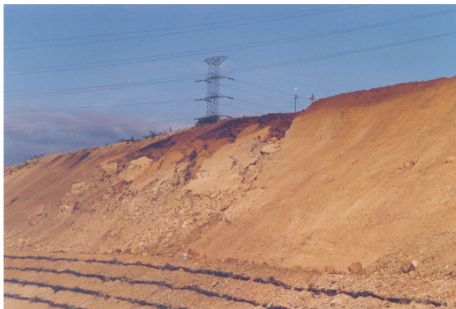
Foto N° 1-2: Deslizamientos en la cara del talud de corte sobre el flanco sur de la Terraza 6 (Octubre 1.993).
