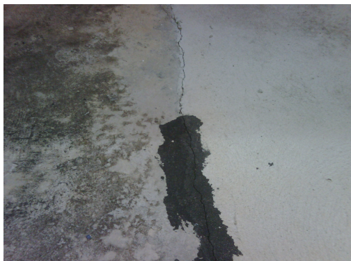
Foto N° 3-1 (izq.): Grieta horizontal en las losas de piso, patio trasero (Enero 2.007).
