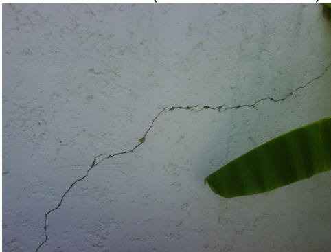
Foto N° 3-32 (izq): Grietas en paredes externas de la vivienda.
