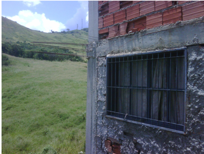
Foto N° 6-2: Malos acabados constructivos (Agosto 2.010).
