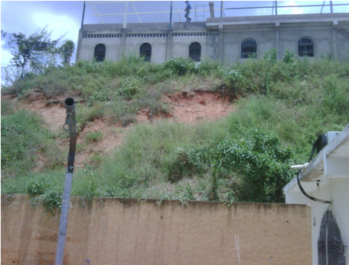
Foto N° 3-23 (izq): Deslizamiento talud patio trasero vivienda 33B (Septiembre 2.010).
