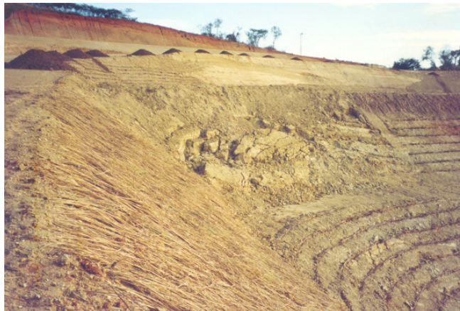
Foto N° 1-5: desprendimiento y corrimiento de material en la Noreste de la Terraza 5. Material de corte arcilloso (Noviembre 1.993).
