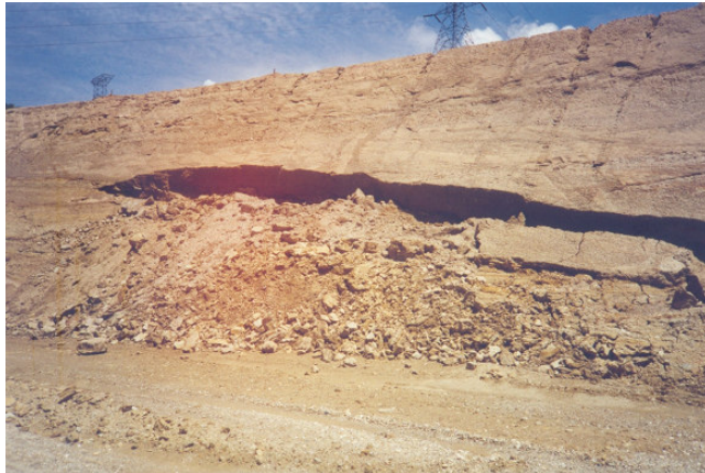
Foto N° 1-1: Primer deslizamiento ocurrido sobre el talud de fondo, entre las Terrazas 6 y 7 (Octubre 1.993).
