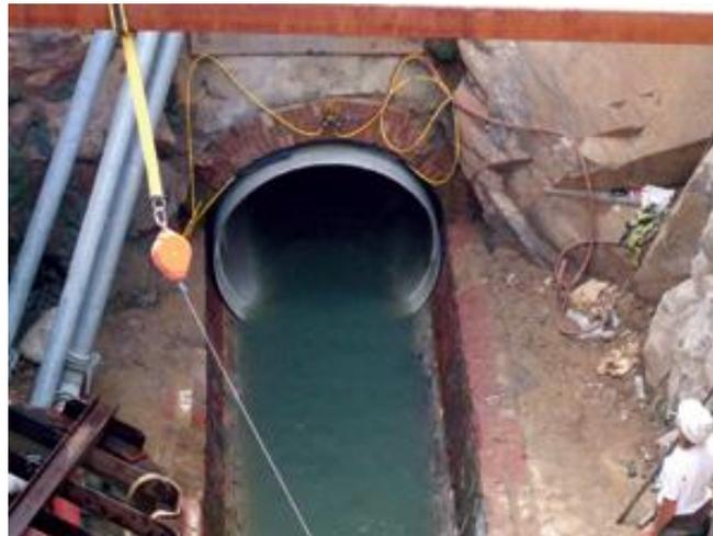
**FIGURA II.10** Segmento de Tubería Instalado [Fuente: Sitio web <http://www.trenchlessonline.com>]
