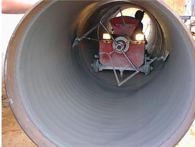
**FIGURA II.12** Aplicación del Mortero de Cemento a una Tubería de Diámetros Superiores de 36 Pulgadas [Fuente: Sitio web <http://www.trenchlessonline.com>]
