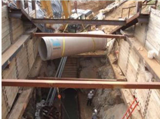
**FIGURA II.9** Segmento de Tubería a Ser Instalado [Fuente: Sitio web <http://www.trenchlessonline.com>]
