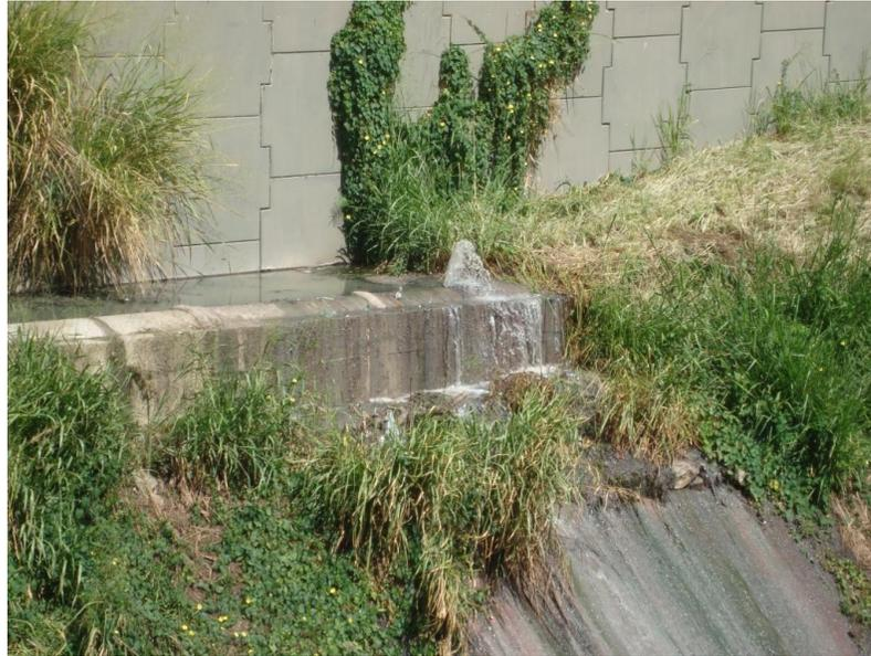
**FIGURA IV.3** Fuga en colector marginal debido a desintegración de la matriz de cemento de las paredes internas.
