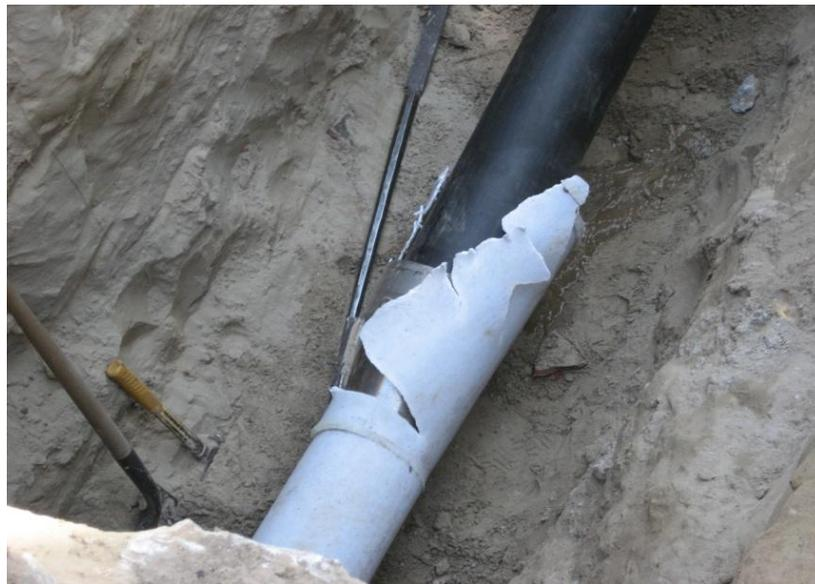
**FIGURA II.10** Proceso Típico de Ejecución de Expansión Dentro de la Tubería
