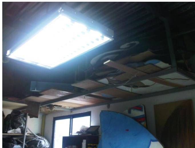
Figura 48.- Material sobrante de arreglos realizados por el personal de mantenimiento. Fuente: Elaboración Propia
