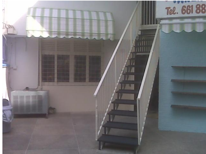
Figura 27.- Escalera de escape de preescolar. Fuente: Elaboración Propia
