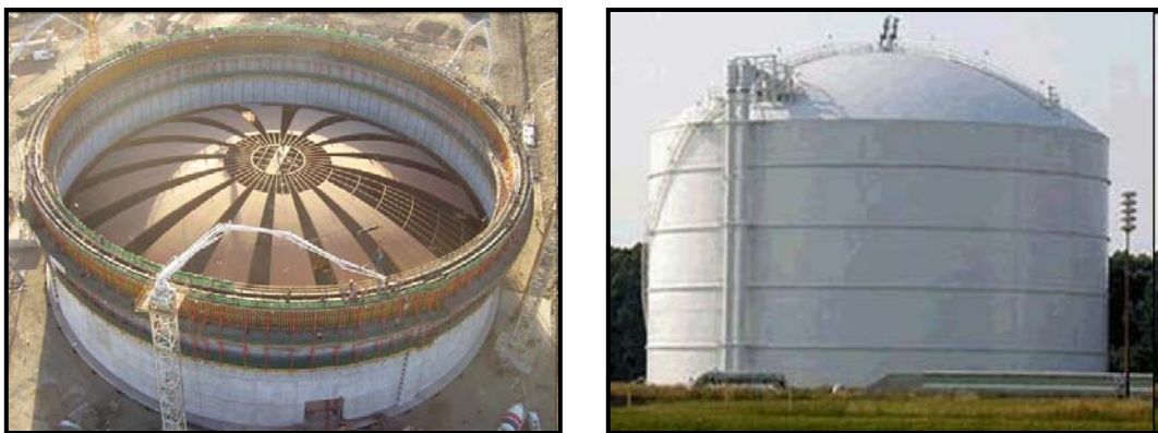
Fig 8. Tipos de Tanques de Almacenamiento de GNL.
