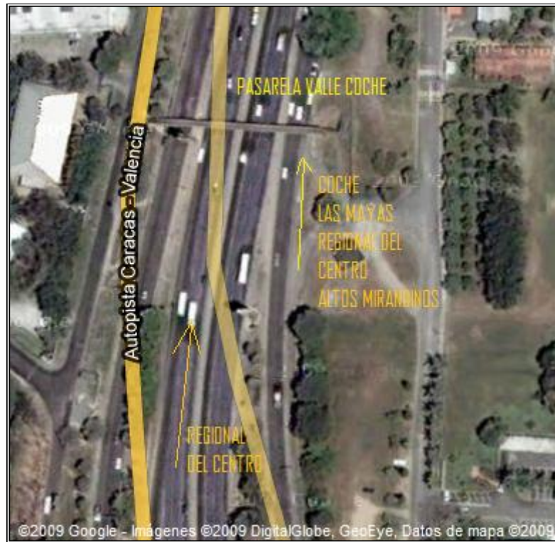
Figura 4B. Vista aérea de la pasarela de Coche en la Autopista Valle Coche y las rutas que llegan a ella. Fuente: Elaboración propia.
