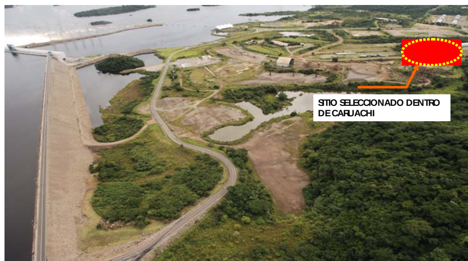
Fotografía 7. Sitio preseleccionado en Caruachi para la construcción del Nuevo Centro de Control de EDELCA
