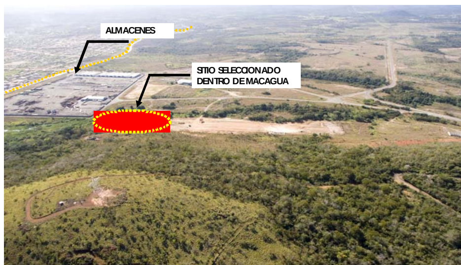
Fotografía 6. Sitio preseleccionado en Macagua para la construcción del Nuevo Centro de Control de EDELCA
