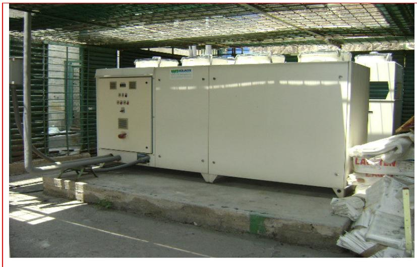
Fig. V.4 Equipo de Refrigeración (CHILLER)
