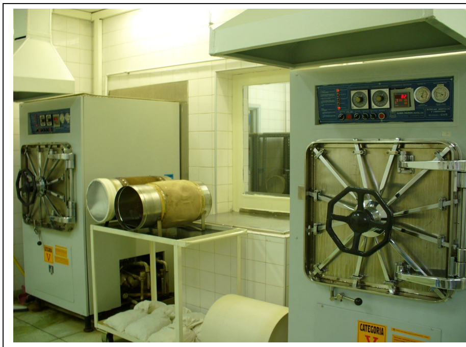
Figura 5. Autoclaves de Doble Puerta del Bioterio de Campina.
