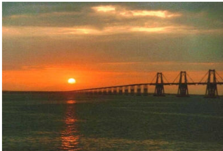
Figura N° 39 Puente sobre El Lago de Maracaibo (Fuente: Estado Zulia, 2009)
