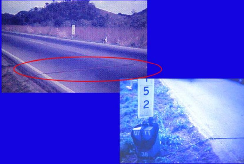
Con este método, los vehículos en general pasan por el dispositivo mostrado y se cuenta un vehículo por eje que detecte el dispositivo. De tal manera, si un camión de mas de un eje pasara sobre la banda neumática el contador haría el conteo de cuantos ejes posea dicho camión
