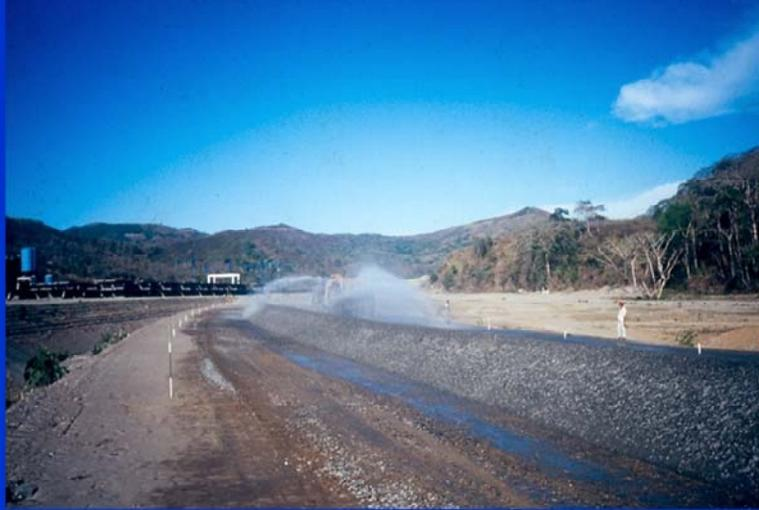
En esta fotografía se puede observar el riego de agua sobre los agregados. El agua no se riega toda al mismo tiempo sino que se distribuye por capas. Se hace un primer riego, la moto niveladora abre una nueva cantidad de material que se coloca sobre el que ya ha sido humedecido. Luego se pasa de nuevo la maquinaria para homogeneizar la humedad. El riego de agua se hace para alcanzar la humedad óptima de manera de lograr su densidad máxima gracias a la compactación del material
