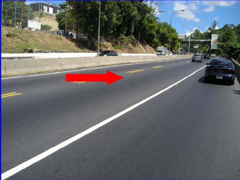
En esta fotografía se observa en otro punto el problema comentado en la lámina anterior. Se observa una falla en el pavimento por permeabilidad. Esta falla sucede luego de la ocurrencia de una lluvia.
