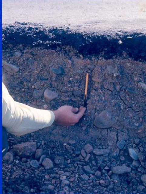
Como se observa en la fotografía, la gradación del granzón natural no es la que generalmente se persigue para la utilización del mismo como material para la sub-base. Aquí se observan fracturas en la capa de sub-base, lo que resulta indeseado para la durabilidad y confiabilidad de un pavimento
