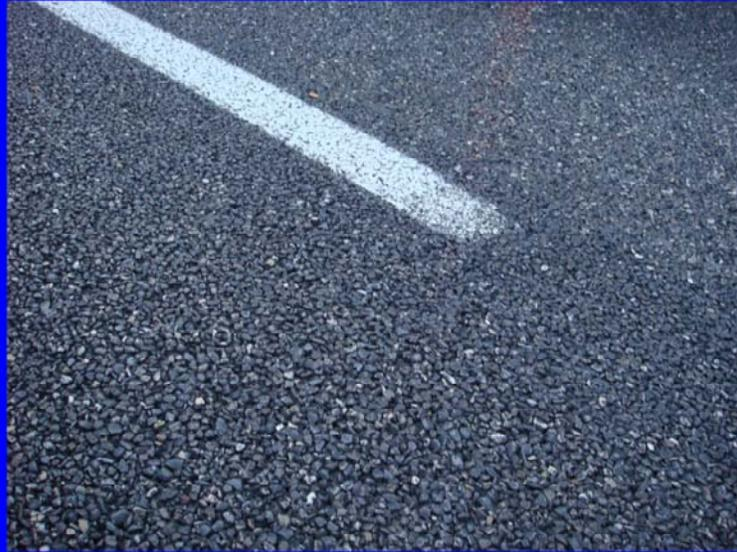
En esta fotografía se observa la mezcla porosa de drenaje de un pavimento. Esta mezcla se caracteriza por poseer agregados con mayores tamaños, lo que pueda derivar en una macrotextura suficientemente gruesa y lograr de esa manera, como ya ha sido discutido, que se aumente la zona de contacto entre el neumático y el pavimento sin presencia perceptible de agua
