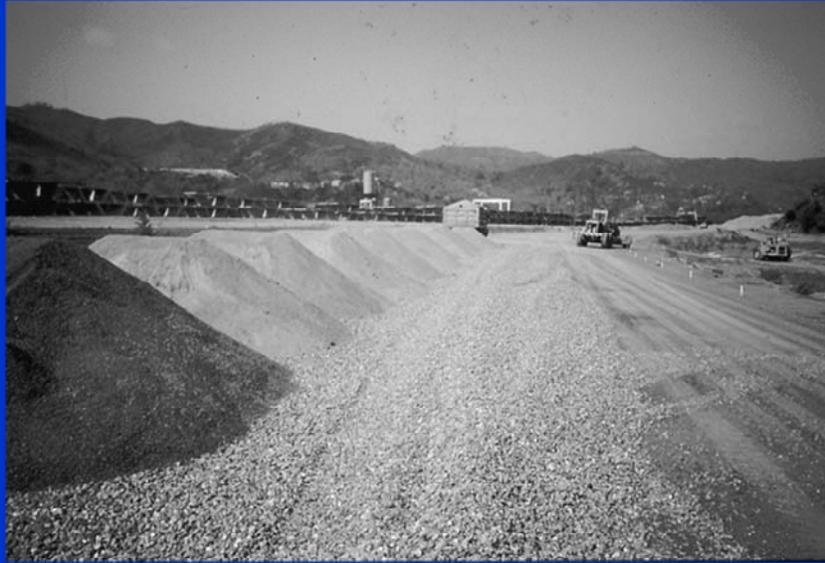
En esta fotografía se muestran las pilas de agregado más fino utilizado para la base ya descargadas y listas para ser extendidas
