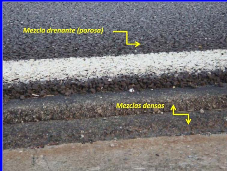
En esta fotografía se observa una vista de mezclas densas y porosas que permiten un funcionamiento deseable en cuanto a permeabilidad. Se puede observar las diferencias granulométricas entre estas mezclas, lo que produce un efecto drenante adecuado sin afectar las capas inferiores de la estructura
