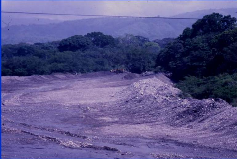
En esta fotografía se puede observar el proceso de explotación en saque de grava de río. se pueden divisar las pilas de agregado que vienen a ser retiradas por la maquinaria necesaria. Este constituye el primer paso en el proceso constructivo de sub-bases granulares no tratadas.
