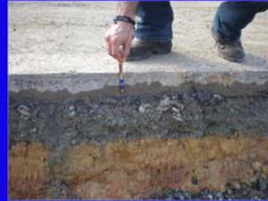
En estas fotografías se puede observar el proceso constructivo de bases y sub-bases granulares. Empieza con la descarga del material en pilas, para luego ser extendido por motoniveladoras y en la fotografía de la derecha se observa un corte transversal del producto terminado.
