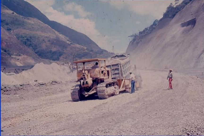
Aquí podemos observar un camión articulado con el material de base seguido por la Spreader que es la maquinaria que colocará el material de base sobre la capa de sub-base
