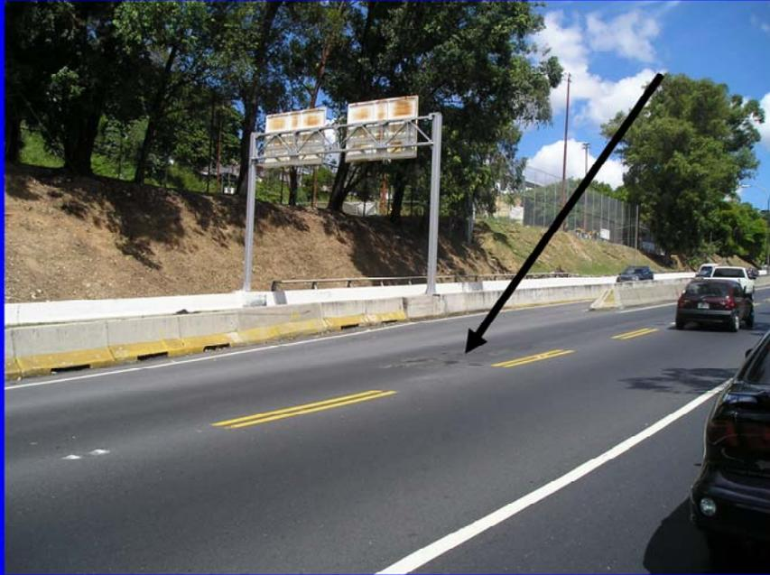
En esta fotografía se puede observar una falla por permeabilidad en el pavimento. Esta fotografía fue tomada en la subida hacia la trinidad. Se observa el cambio en la coloración del pavimento ya que el agua permea hacia arriba. Este pavimento fue construido sobre una base de tableros de concreto. Es por eso que el agua permea hacia arriba
