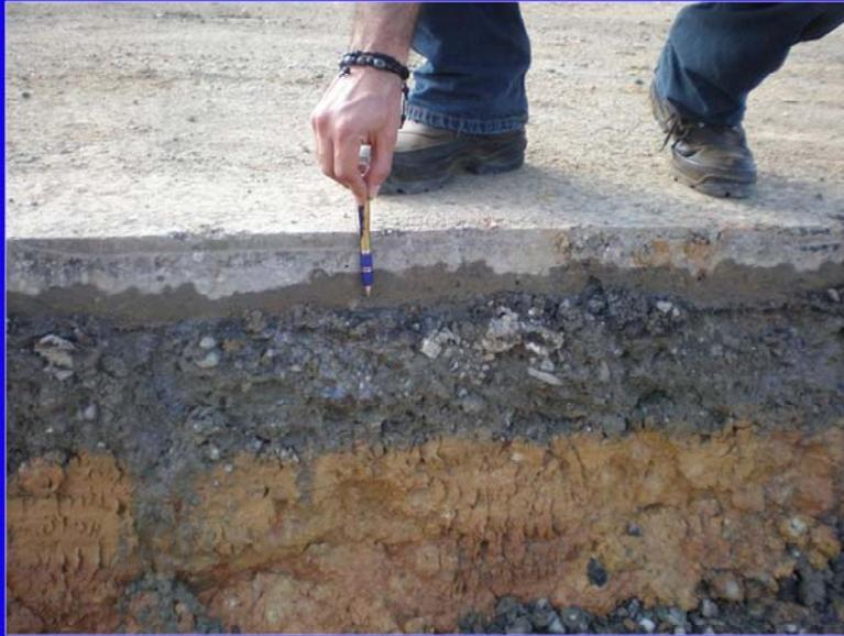
Esta fotografía muestra la sección estructural de un nuevo pavimento, en la que se pueden identificar claramente las capas que lo componen: en la superficie se encuentra la capa de rodamiento, en este caso hecha de cemento, la base, sub-base y sub-rasante. Aquí se puede observar que los materiales utilizados para conformar cada capa no pueden ser iguales y cada uno debe tener propiedades específicas de modo de que puedan transmitir y soportar las cargas más eficientemente
