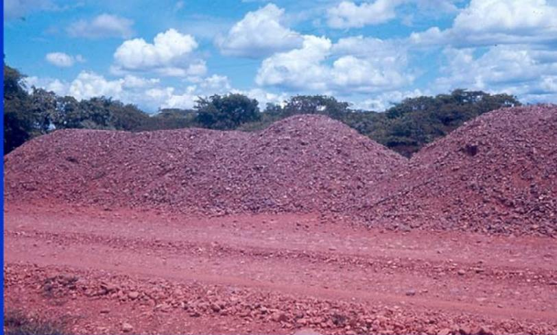
En esta fotografía se puede observar que las pilas de agregados ya han sido colocadas, lo que las dejaría listas para extenderlas hasta el espesor de proyecto.
