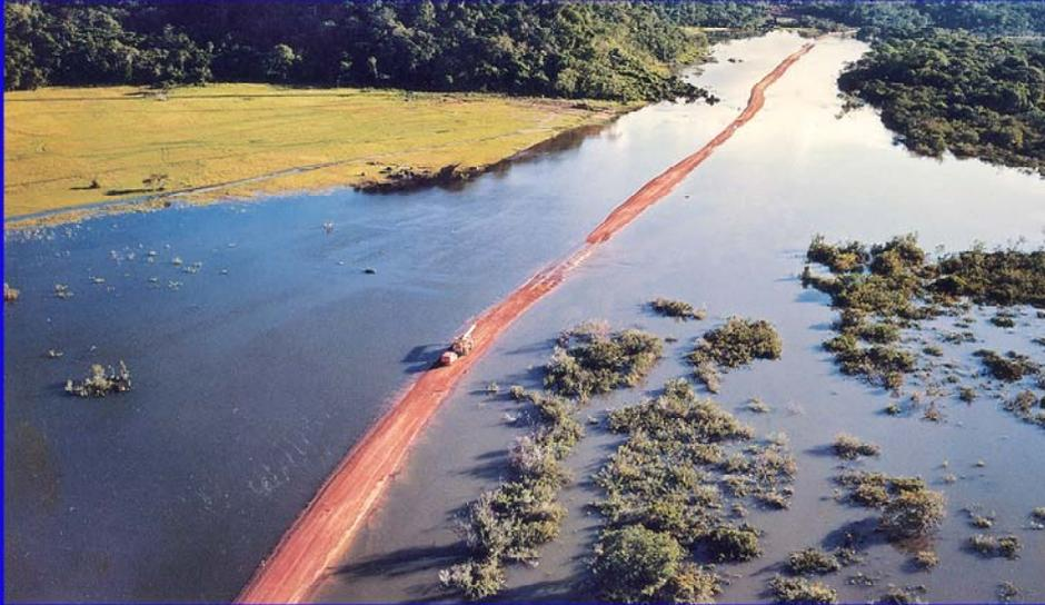
A la hora del diseño de pavimentos, como se puede observar en la fotografía, las condiciones climáticas deben ser consideradas. En este caso no lo fueron y como se ilustra, la vía se encuentra rodeada de agua producto de una inundación.
