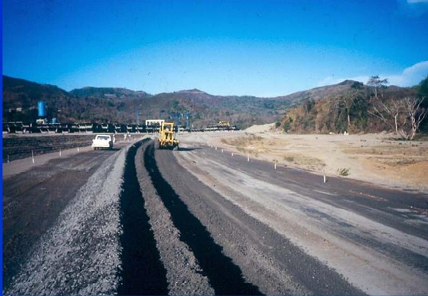
En esta fotografía se observa el paso de la maquinaria mezcladora de las capas de material que conformarán la base
