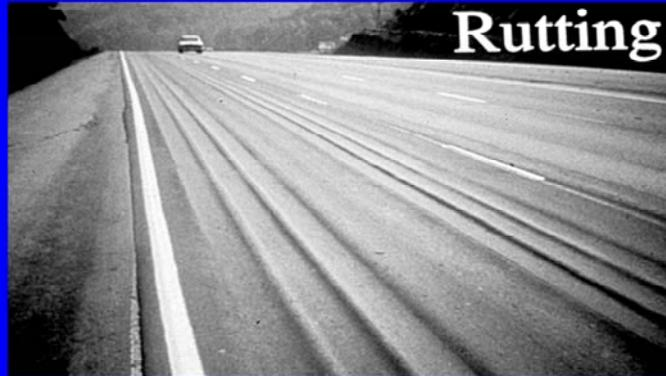
Los pavimentos con baja estabilidad sufren ahuellamientos (como lo que se observa en la fotografía superior, que es una falla que causa especies de canales por donde pasan los cauchos de los vehículos)
