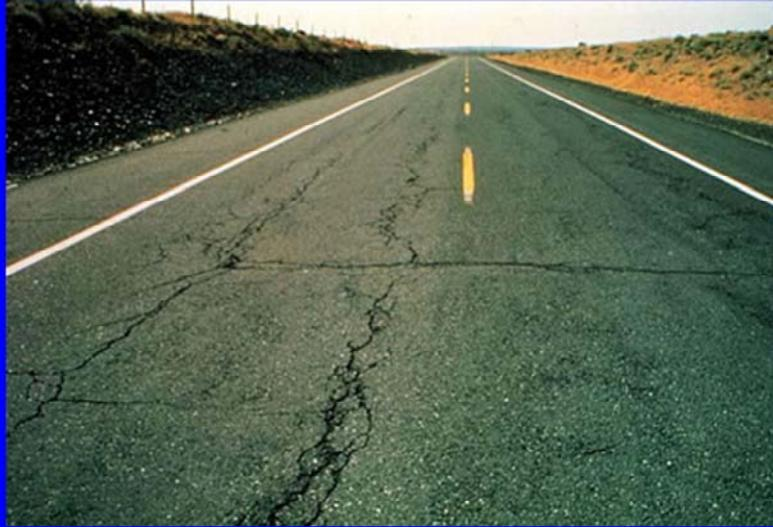
El agrietamiento por fatiga térmica no es una falla común en Venezuela, ya que al no tener fluctuaciones marcadas de temperatura no dan paso a que el pavimento se contraiga o expanda y se agriete
