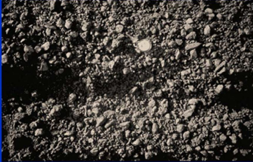
En esta fotografía se puede observar la apariencia final de la capa de base luego de haber sido mezclada por la maquinaria correspondiente. Se nota que la apariencia es uniforme, lo que indica que el material está bien mezclado.
