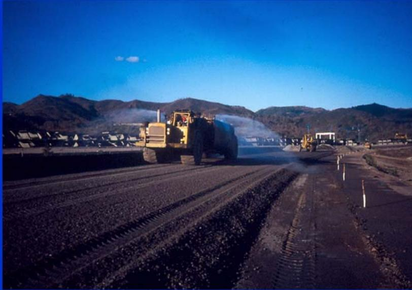
En esta fotografía se puede observar el riego de agua sobre los agregados. El agua no se riega toda al mismo tiempo sino que se distribuye por capas. Se hace un primer riego, la moto niveladora abre una nueva cantidad de material que se coloca sobre el que ya ha sido humedecido. Luego se pasa de nuevo la maquinaria para homogeneizar la humedad. El riego de agua se hace para alcanzar la humedad óptima de manera de lograr su densidad máxima gracias a la compactación del material
