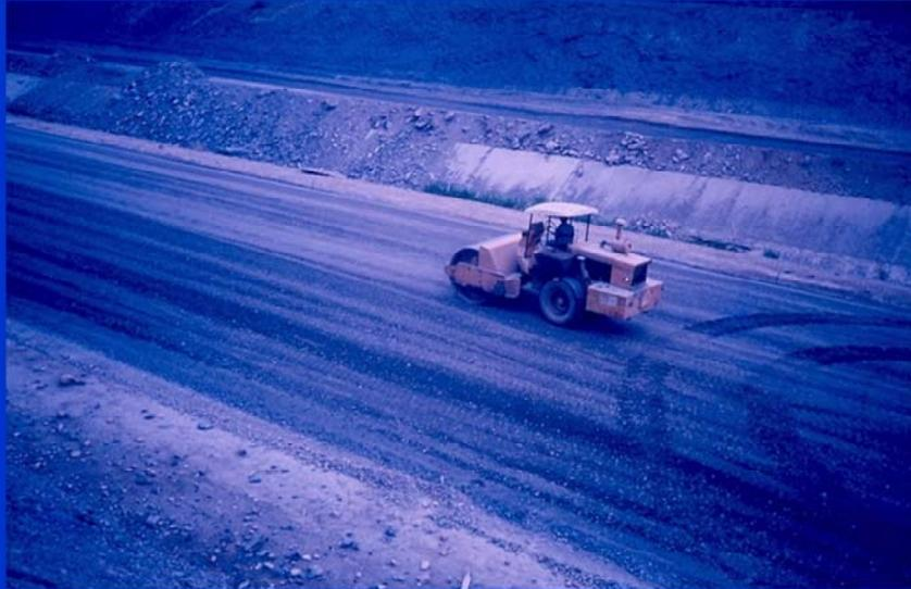
En esta fotografía se muestra el proceso de compactación y nivelación del material de la base que ya ha sido mezclado pertinentemente
