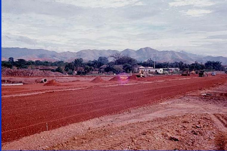
En esta fotografía, como el título lo indica, se muestra el proceso de extendido del material de modo de alcanzar el espesor y nivel de proyecto. Se puede observar que ya el material ha sido parcialmente extendido.
