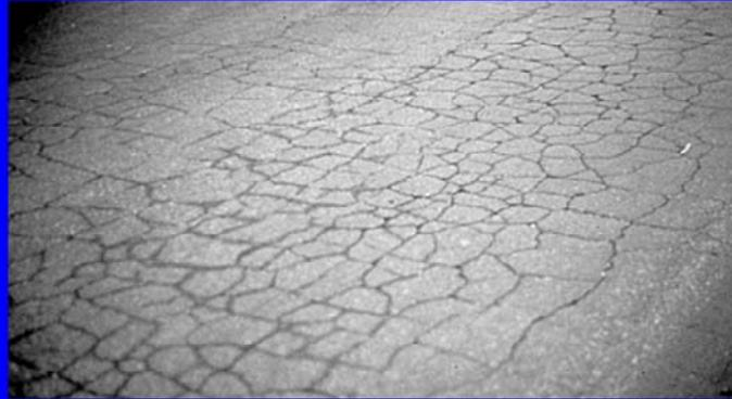
*Agrietamiento tipo "piel de cocodrilo", por efecto de la fatiga de la mezcla*
