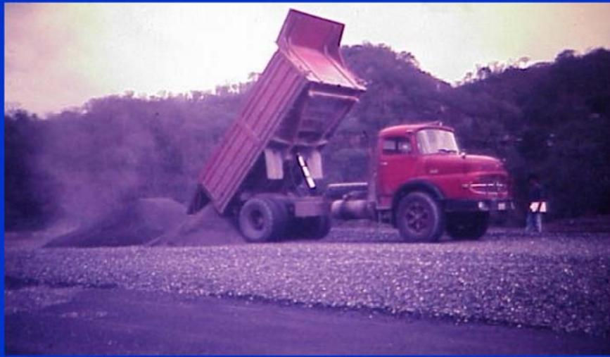
En esta fotografía ya se ha descargado, extendido y compactado el primer material de base. Entonces se observa la descarga del material más fino sobre esta capa
