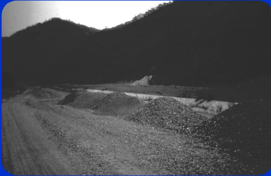
En esta fotografía se muestra la disposición de las pilas de agregados como lo hemos descrito anteriormente. Nuevamente se resalta que la distancia entre estas pilas NO es aleatoria y debe ser calculada en función del volumen que se necesite de agregado y de la capacidad de los camiones que se utilicen para tal fin. Así se observa, entonces, dos agregados distintos con sus separaciones correspondientes
