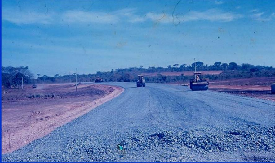
Aquí se observa como se compacta y nivela el material de la base de modo de obtener una superficie lo más regular posible para que el pavimento tenga el mejor acabado que se le pueda dar.
