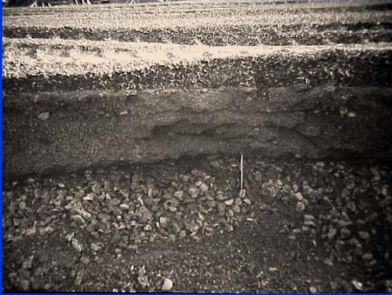
En esta fotografía se observa un detalle del extendido de los diferentes materiales. Luego de que este proceso esté listo, se mezclarán las distintas capas que observamos aquí y luego serán compactadas para obtener la base que deseamos.
