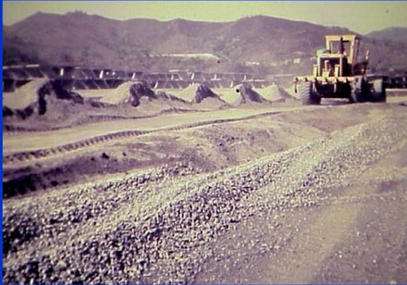
En esta fotografía se observa el encamellonado del material de base por la maquinaria correspondiente.
