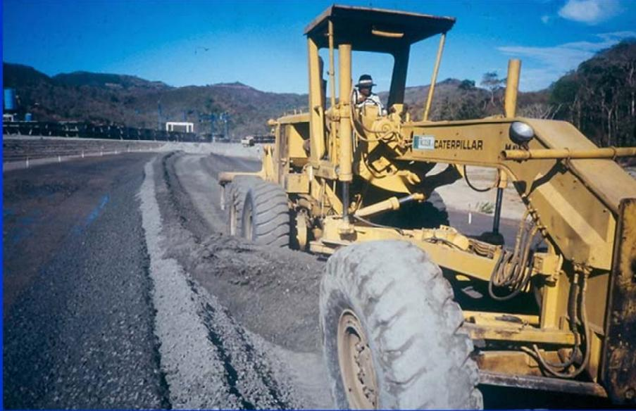
Aquí podemos observar el material que vimos anteriormente en capas siendo mezclado. Después de esto será necesario compactar el nuevo material mezclado y nivelarlo para poder colocar entonces la mezcla asfáltica que terminará el proceso de construcción de la estructura del pavimento
