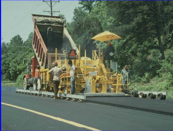
Colocación de mezcla asfáltica: en la foto se observa una máquina finisher en funcionamiento. El camión descarga la mezcla donde unos tornillos sin fin empujan y traen la mezcla. A través de sensores la maquina va adelantando y extendiendo la carpeta. La mezcla será de fácil colocación mientras tenga menor contacto con máquinas.
