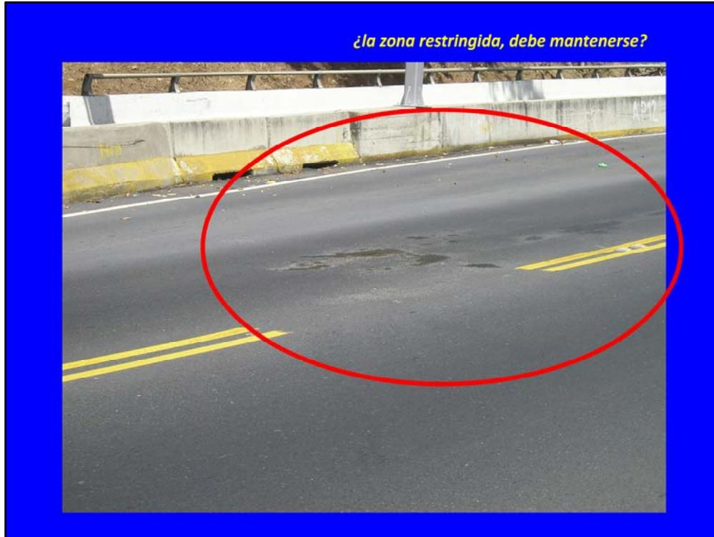
En esta fotografía se observa con más detalle el problema comentado en la lámina anterior. Se observa una falla en el pavimento por permeabilidad. Esta falla sucede luego de la ocurrencia de una lluvia.
