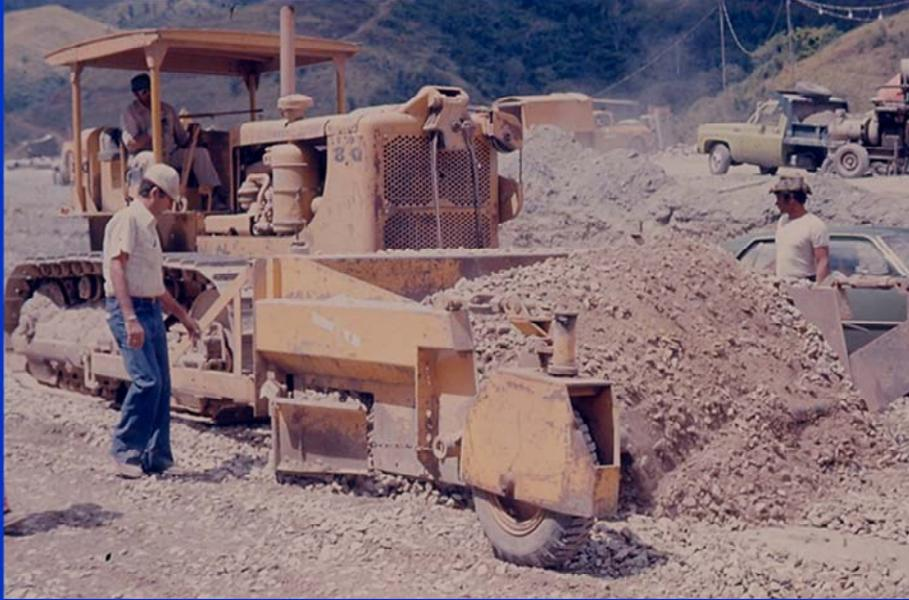
Existen otras maneras de mezclar el material utilizado para la capa base. En este caso se observa un Spreader (extendedora) que mezcla el material y luego dispone de él sobre la capa de sub-base.
