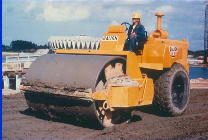
En esta fotografía se observa el proceso de compactación del material extendido. Como ha sido mencionado, una vez humedecido el material se procede al paso, nuevamente, de la maquinaria de modo de homogeneizar la humedad y se obtenga, de esta manera, la densidad del proyecto.
