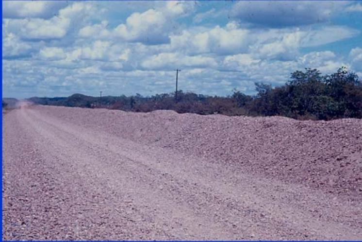
En esta fotografía se ilustra como se ha extendido, en parte, los agregados, de manera que se forma el llamado "cordón" o "camellón". El camellón es una pila de menor altura y continua que se forma cuando la cuchilla corta la pila del material y la empuja a un lado
