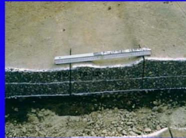
En esta fotografía podemos observar una deformación permanente por cargas o ahuellamiento, que puede presentarse por una diversidad de causas como exceso de asfalto en la mezcla, agregados de partículas redondeadas, etc. Y que se presenta físicamente como una especie de “canales” en dirección longitudinal de la vía.
