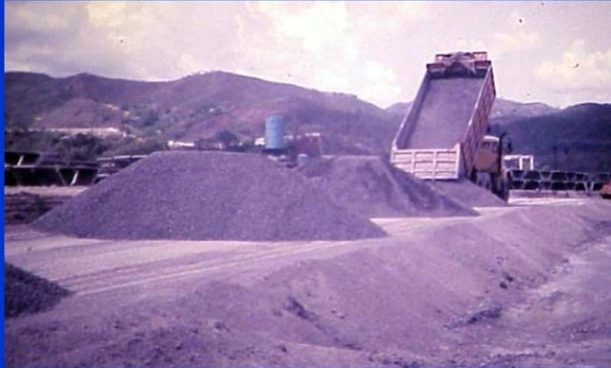
En esta fotografía se puede observar la descarga del material utilizado como segunda capa de base, que luego será extendido y compactado para luego ser mezclado con las otras capas de material. A este proceso se le llama de “sandwich”
