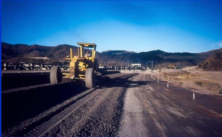
Aquí podemos observar el material que vimos anteriormente en capas siendo mezclado. Después de esto será necesario compactar el nuevo material mezclado y nivelarlo para poder colocar entonces la mezcla asfáltica que terminará el proceso de construcción de la estructura del pavimento
