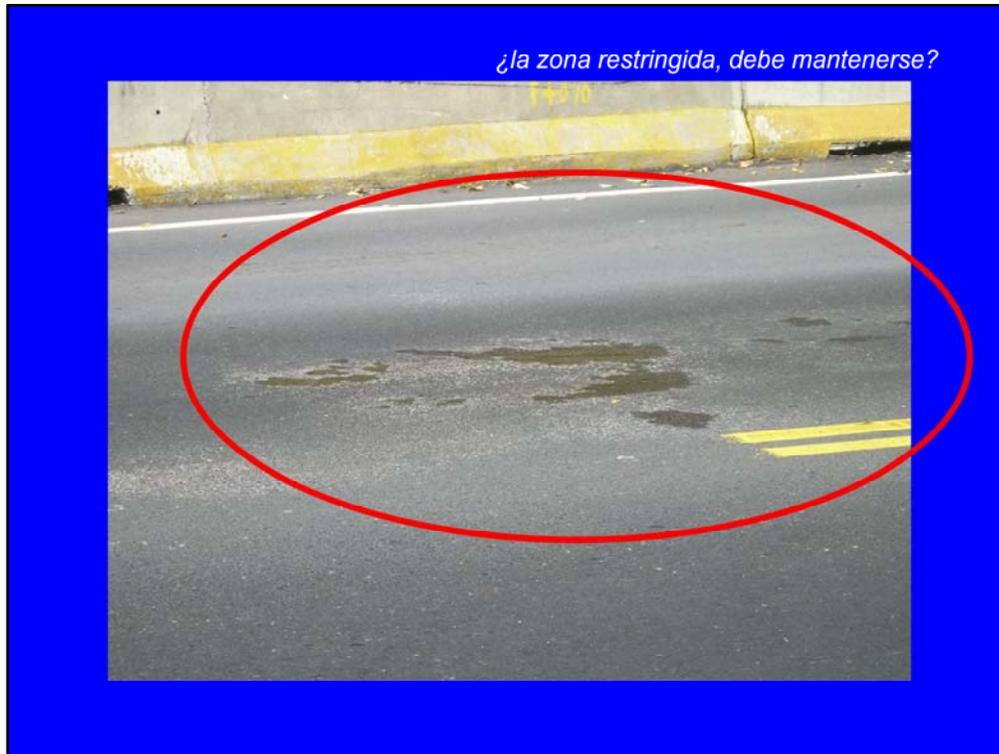
En esta fotografía se observa en detalle una falla por permeabilidad. Se debe notar un cambio en la coloración del pavimento
