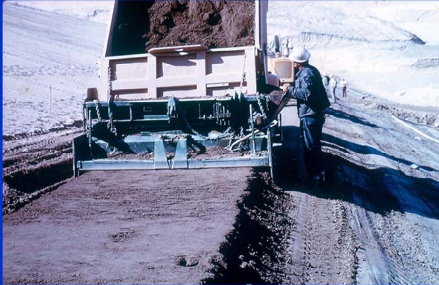
Aquí se observa aun otro método de colocación del material de la capa base. Se nota, entonces, que el material también se puede extender con equipos para distribuir mezcla asfáltica (Finisher)
